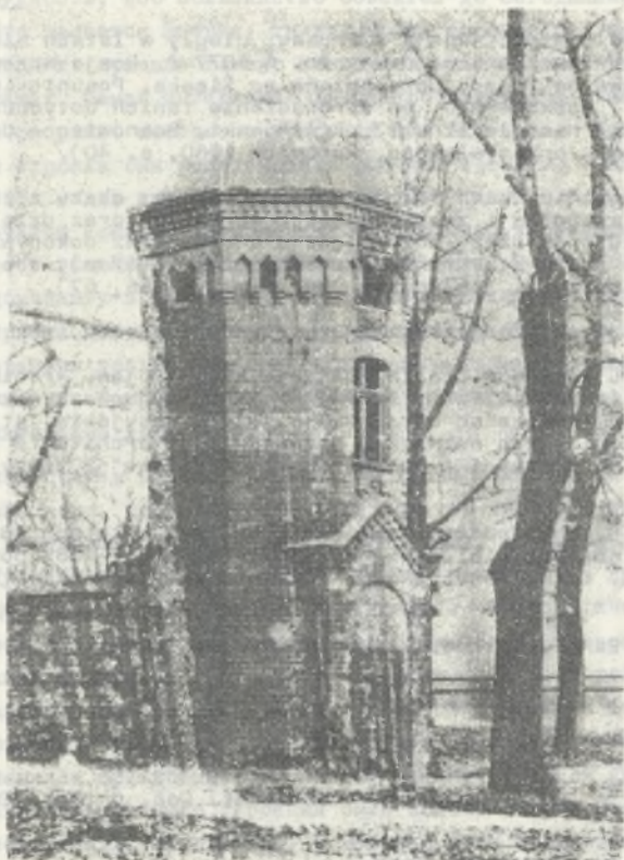
Ryc. 15. Stacja transformatorowa dworu Sielec z 1913 r. - stan obecny Fig. 15. Transformer station in Sielec manor of 1913. The present state
