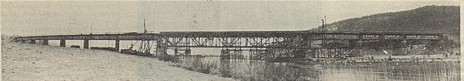
Abb. 7. Zweigleisige Eisenbahnbrücke über die Weser bei Wehrden.
