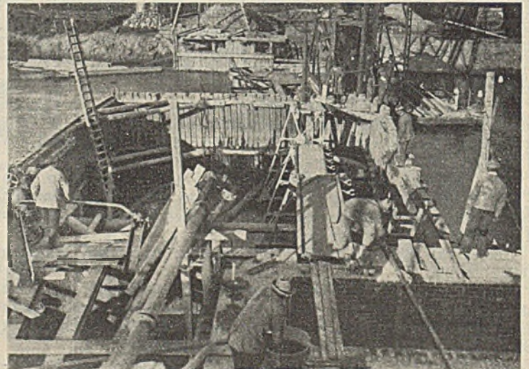
Abb. 12. Blick in den Spundwandkasten der linken Wehrhälfte. Ausbau der Versteifung (s. Abb. 13 u. 14).
