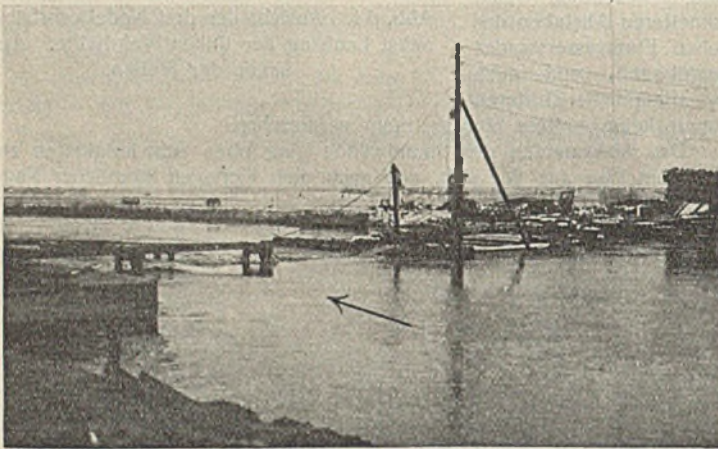
Abb. 21. Spundwandkasten der rechten Wehrhälfte (II. Bauabschnitt) überflutet (vom Oberwasser aus gesehen).
