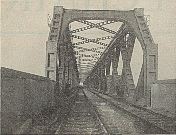
Abb. 4. Neuer Überbau der Rheinbrücke bei Wesel, Durchblick.
