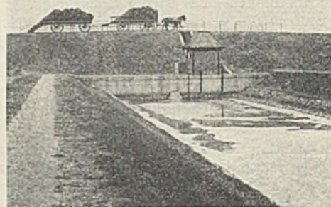
Abb. 9 zeigt, vom Pumpwerk aus gesehen, die Anrampung des Elbdeiches über dem Heber, den eingedeichten Verbindungsgraben zwischen Pumpwerk und Heber, Bedienungshäuschen und Heberausmündung.
