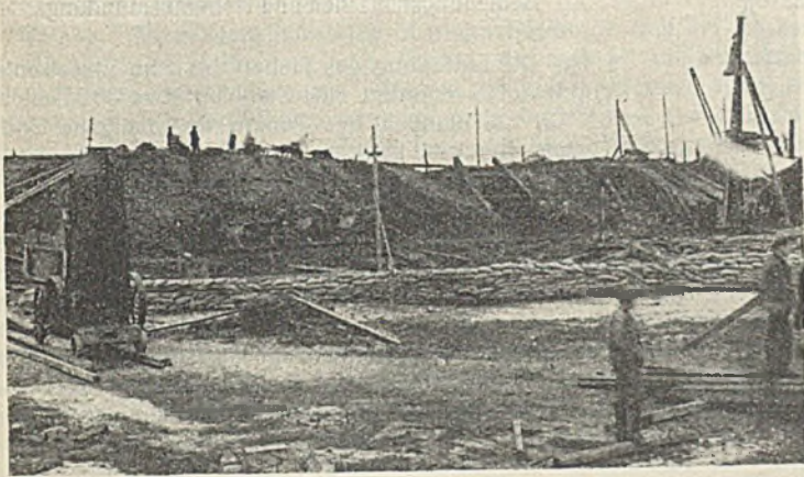
Abb. 7. Die ersten Sicherungsmaßnahmen.
