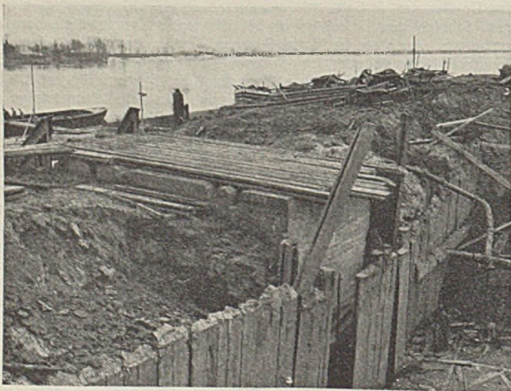
Abb. 5. Der versackte Schacht.
