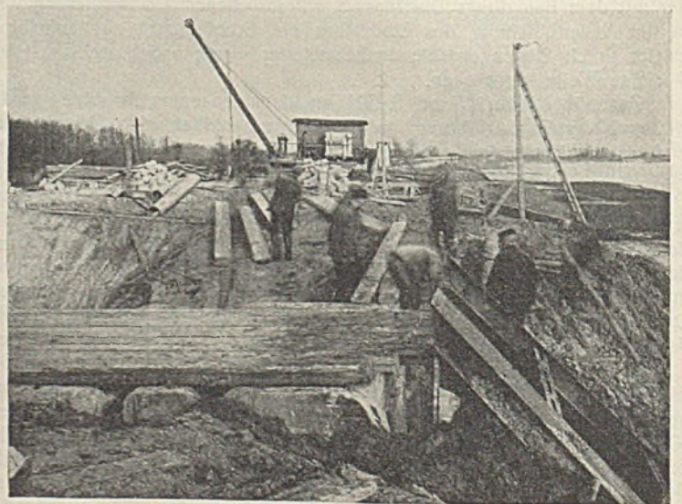
Abb. 6. Der versackte Schacht.
