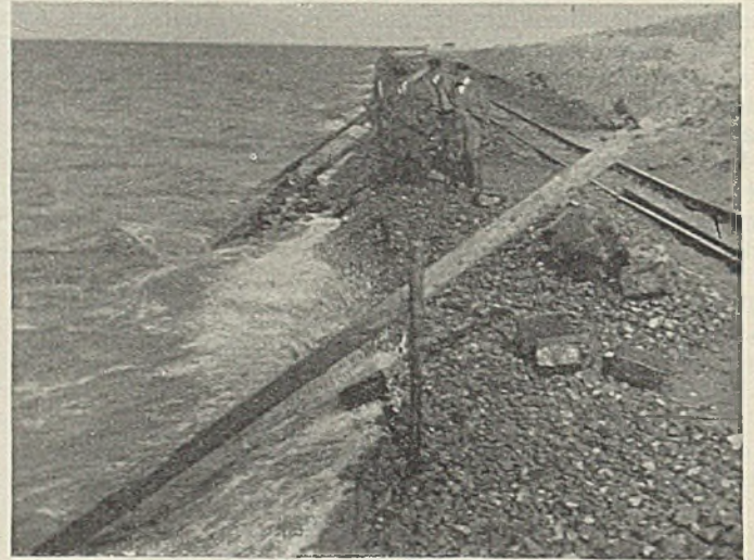
Abb. 14. Herrichtung der Pflasterunterbettung.
