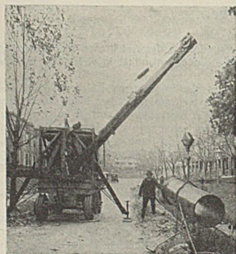
Abb. 3. Autokran beim Einlegen von Rohren (seitliche Schraubstützen aufgestellt).
