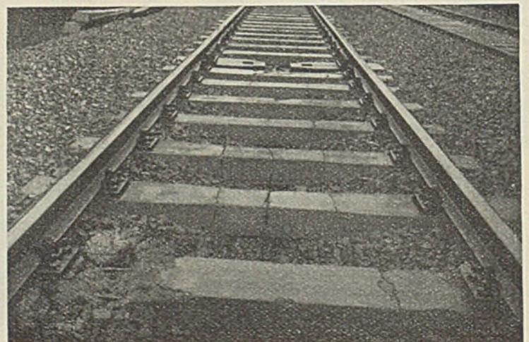
Abb. 3. Betonschwellen ohne Gelenk.
