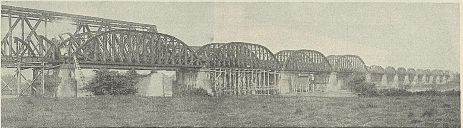
Abb. 1. Elbebrücke bei Hämerten. Ansicht der alten Brücke. Die östlichen Landüberbauten sind bereits abgebrochen.
