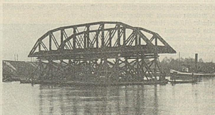
Abb. 11. Havelbrücke bei Rathenow. Ausschwimmen eines Stromüberbaues.
