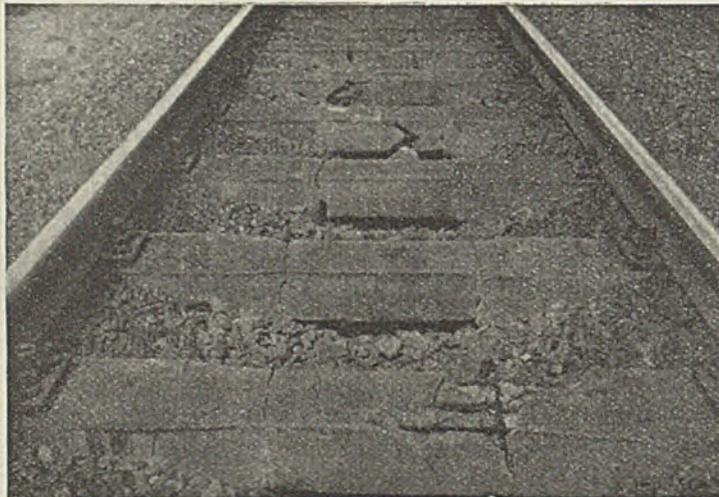
Abb. 1. Betonschwellen ohne Gelenk.
