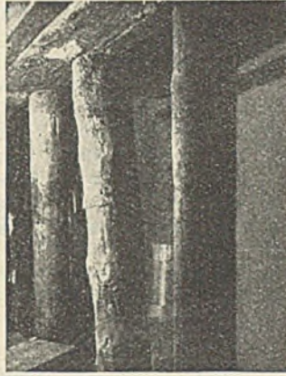
Abb. 11. Baugrube unter Pfeiler III.
