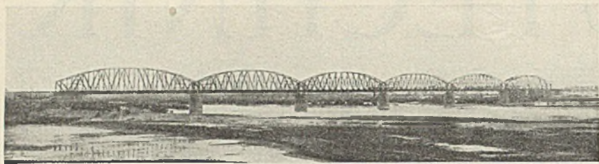
Abb. 1. Gesamtansicht der Mosyrbrücke.
