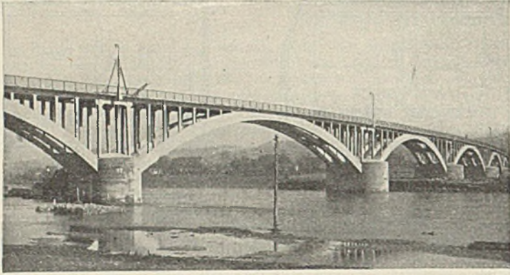
Abb. 3. Brücke über die Weser bei Vlotho. Lichtweite der Stromöffnung 60,96 m. Ausführung: Beton- und Monierbau A.-G.
