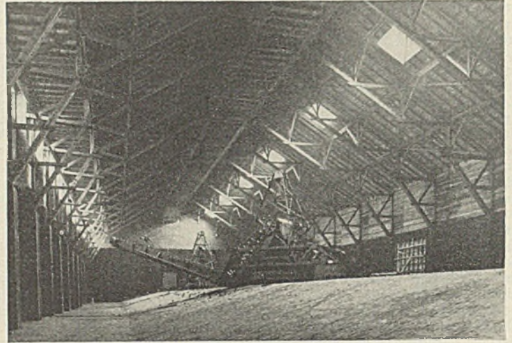
Abb. 5. Innenansicht eines Mittelschuppens mit zwei Kratzern.
