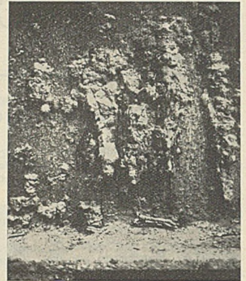
Abb. 4. Rostausbildungen an einer Torwand.
