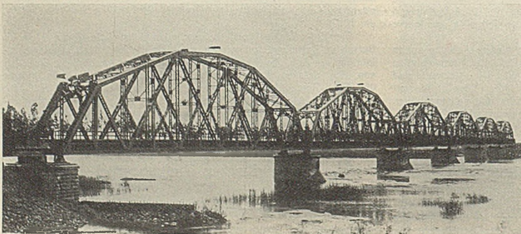
Die neue Weichselbrücke bei Sandomierz.
