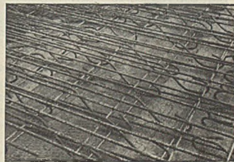
Abb. 25. Vorbildliches Verlegen von Eiseneinlagen für die Schaltbühne.
