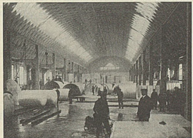
Abb. 46. Maschinenfabrik Ziemann. Innenansicht.
