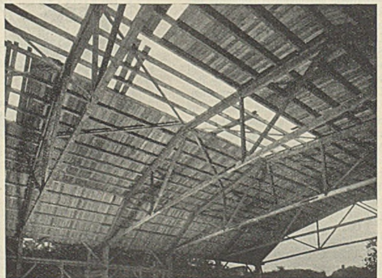
Abb. 23. Untersicht der Dachkonstruktion des Geräteschuppens in Berlin-Siemensstadt.
