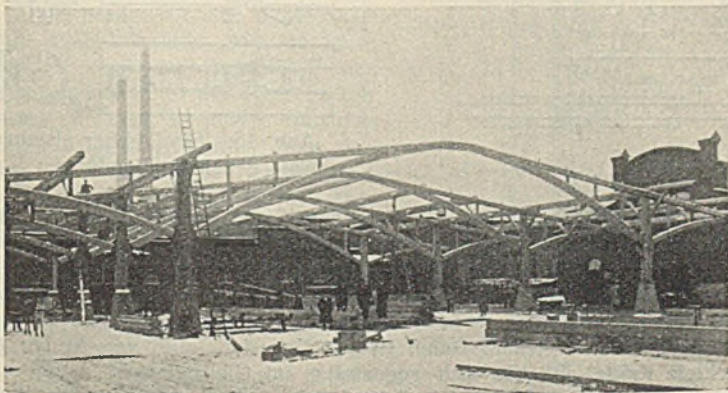
Abb. 13. Wagenhalteplatz Zwickau während der Ausführung.
