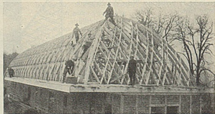
Abb. 60. Giebelansicht der Kornlagerhalle während der Ausführung.
