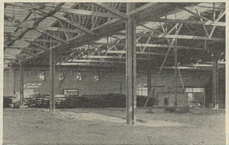
Abb. 26. Kajeschuppen Bremen. Innenansicht gegen einen Unterzug mit Stützen.
