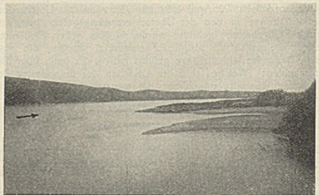
Abb. 7. Umfang der Verlandung eines Bühnenfeldes (Weichsel bei Dirschau; NW) [von der stromauf gelegenen Buhne aus gesehen].
