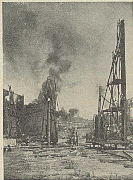
Abb. 3. Rammen der Mastpfähle.
