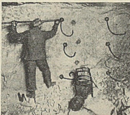
Abb. 5. Besetzen der Bohrlöcher mit Oxyliquitpatronen im Stollenvortrieb.
