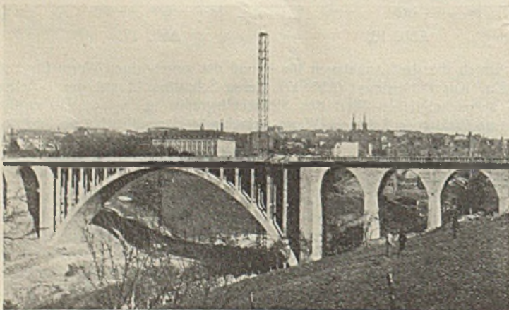
Abb. 8. Streckbrücke in Pirmasens. Ausführung Wayss & Freytag A.-G., Neustadt a. d. H.
