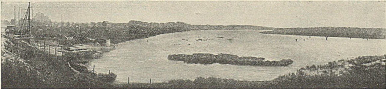
Abb. 2. Das vor Errichtung des Baupumpwerks ständig überflutete Schwelgernbruch.
