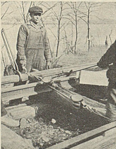
Abb. 4. Zusammenpressen und Bündeln der Litzen.
