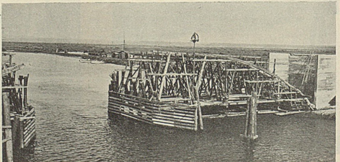
Abb. 14. Lehrgerüst der rechten Öffnung mit Schiffsdurchlaß, rechtes Widerlager ausgeschalt.
