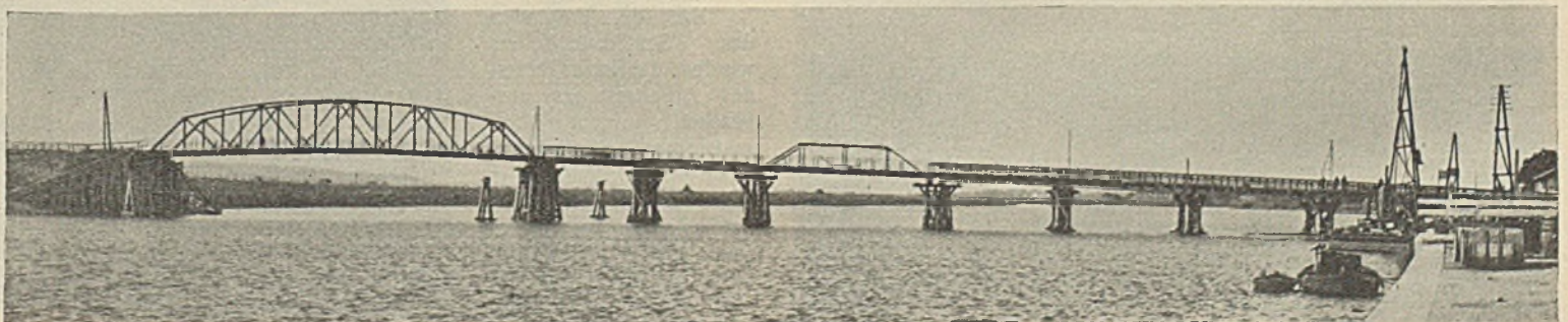
Abb. 2. Behelfsbrücke oberhalb der alten Holzbrücke.
