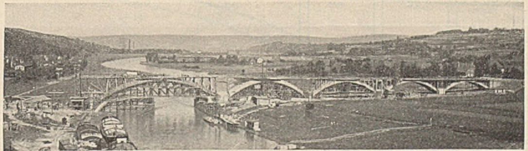
Abb. 51. Brücke über die Weser bei Vlotho.
