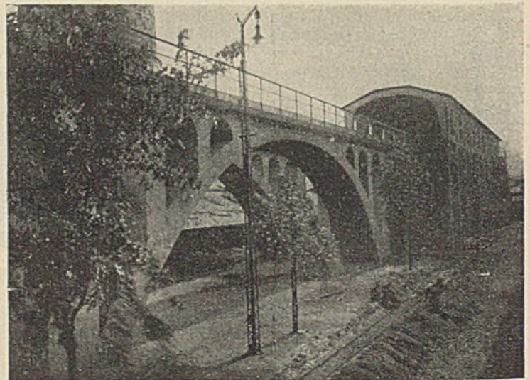
Abb. 21. Kohlenhochbahn auf Grube Marga.
