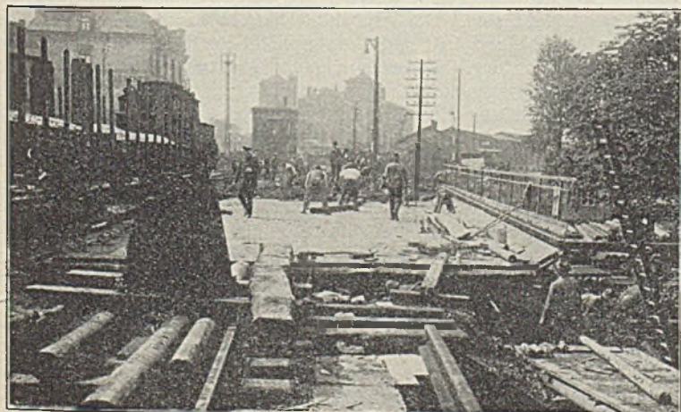
Abb. 12. Nach der Einschlebung des rechten Brückenteiles.
