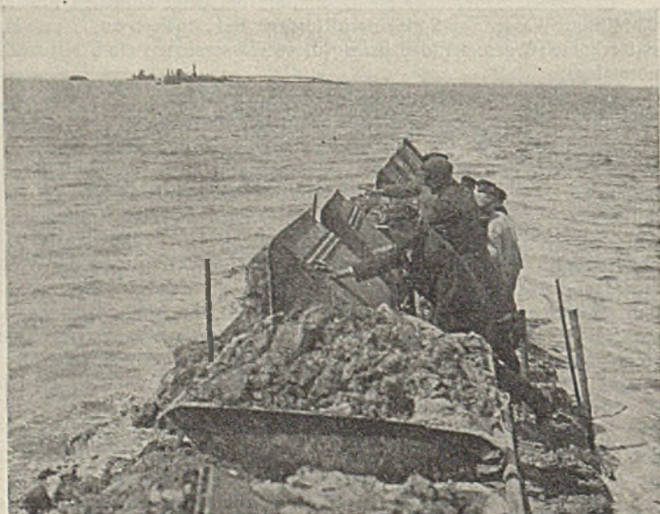
Abb. 4. Vom Festlande aus vorgeschütteter Kleidamm. Im Hintergrunde Naßbaggergeräte im Osterley.
