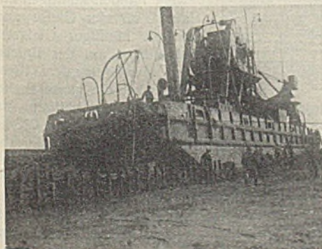
Abb. 6. Auf den Resten der Spülfläche im Osterley gestrandeter Bagger.
