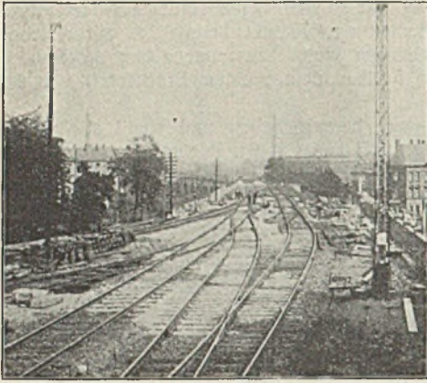
Abb. 14. Fertigstellung des Verbindungsfeldes.
