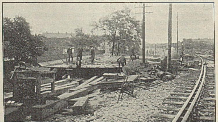
Abb. 11. Der außerhalb der Gleise zusammengebaute rechte Brückenteil.
