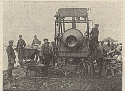
Abb. 8. Kapezett-Schnellmischer mit eingebauter Winde. Maschinenfabrik Karl Peschke, Zweibrücken.
