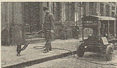
Abb. 11. Druckluft-Aufrauher für Pflaster. Maschinenfabrik G. A. Schütz, Wurzen.
