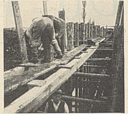
Abb. 10. Pfahlgründung für die Unterführung eines Entwässerungsgrabens unter der Schutter hindurch mit Zementrohren.
