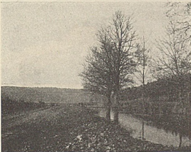
Abb. 2. Eine Schutterflußstrecke im bisherigen Zustande.
