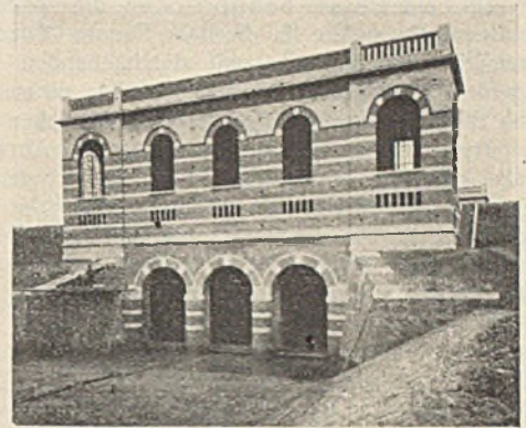
Abb. 39. Bonifica Parmigiana-Moglia. Durchlaß bei San Prospero. Einlauf.
