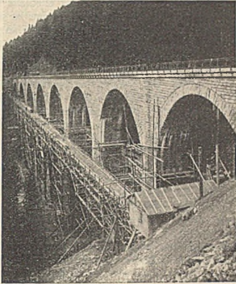
Abb. 41. Talübergang (Südseite) vor Inbetriebnahme.
