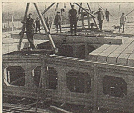
Abb. 55. Bonifica Parmigiana-Moglia. Pumpwerk Bondanello. Dachkonstruktion.
