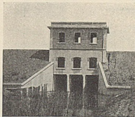
Abb. 13. Bonifica Renana. Durchlaß für den Canale Lorgana (Botte del Vescovo). Fertiges Bauwerk.
