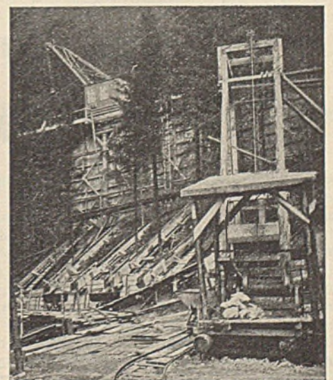
Abb. 14. Aufzug für Pfeiler 9, Silo und Entladekran.
