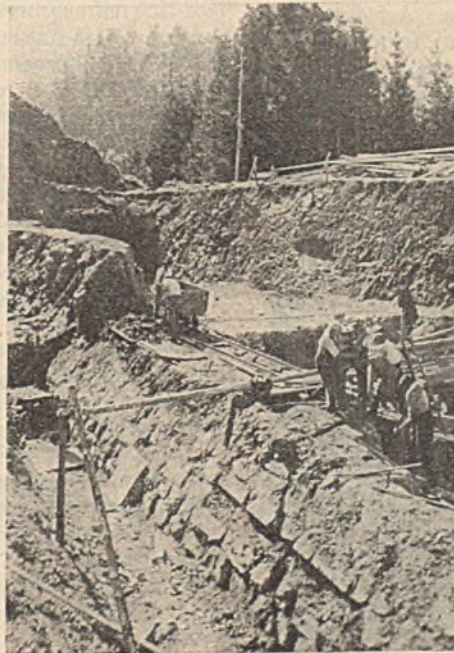
Abb. 45. Freilegen des Tunnelgewölbes.
