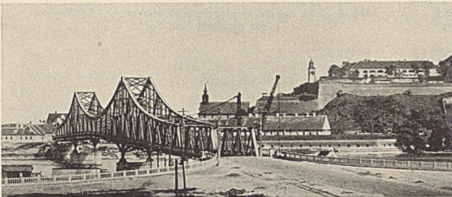
Abb. 8. Ansicht der neuen Brücke von Novi-Sad aus.
