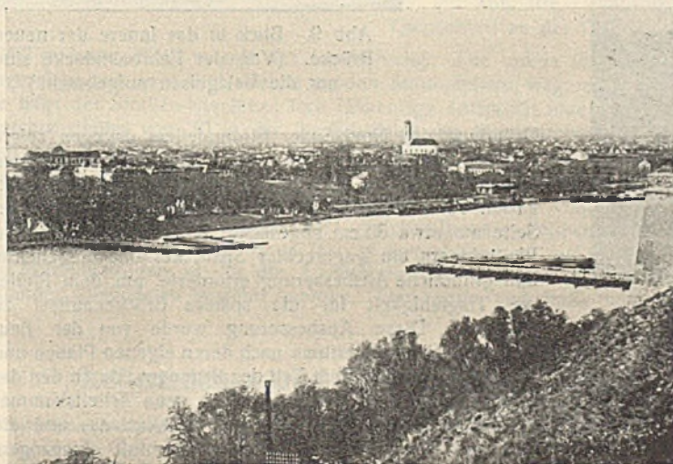
Abb. 3. Blick auf die Stadt Novi-Sad mit der ausgefahrenen Schiffbrücke von der Festung Peterwardein.
