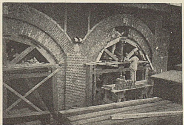
Abb. 6. Mauern der Gewölbe. Bogen 2 vor dem Ausschalen. Bogen 3: Mauern des Scheitels.
