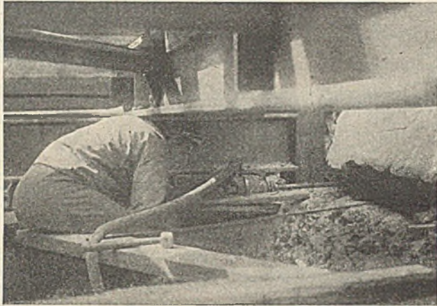
Abb. 2. Bohren der Löcher für die Verankerung der Stirnwände.
