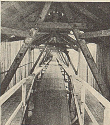
Abb. 10. Einspeicherband im Schuppenfirst.
