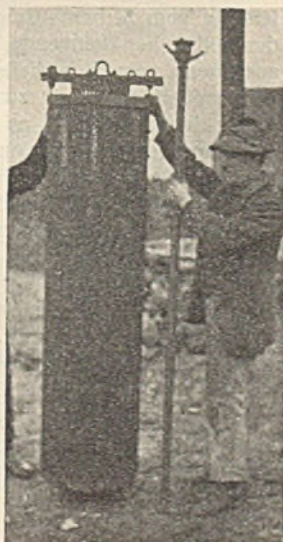
Abb. 2. Sicherheitspumpensumpf mit Spülstange.
