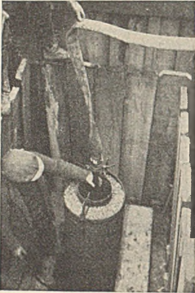
Abb. 6. Sicherheitspumpensumpf kurz vor dem Einspülen.
