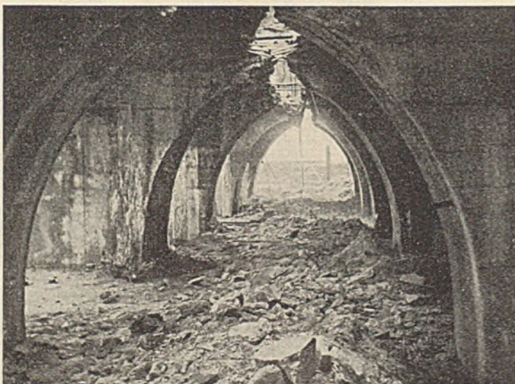
Abb. 2. Durchblick zwischen den Pfeilerreihen A und B nach der ersten Sprengung.
