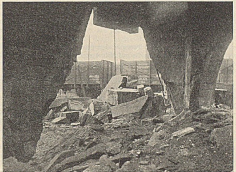
Abb. 3. Pfeiler A1 (rechts) und A2 (links) nach der Versuchssprengung.
