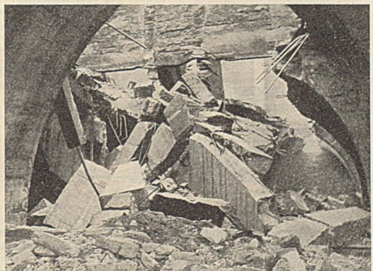
Abb. 4. Blick auf die stehengebliebene Mittelwand über dem Pfeilerpaar B3—B4.
