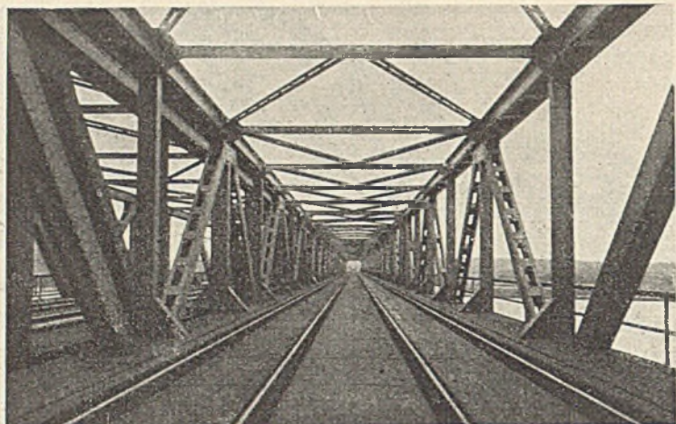
Abb. 4. Blick in die neue Brücke.
