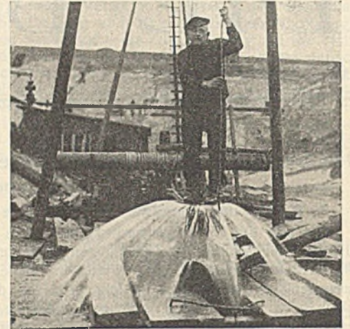
Abb. 3. Wasserandrang beim Vortreiben der Bohrrohre für die Tiefbrunnen.
