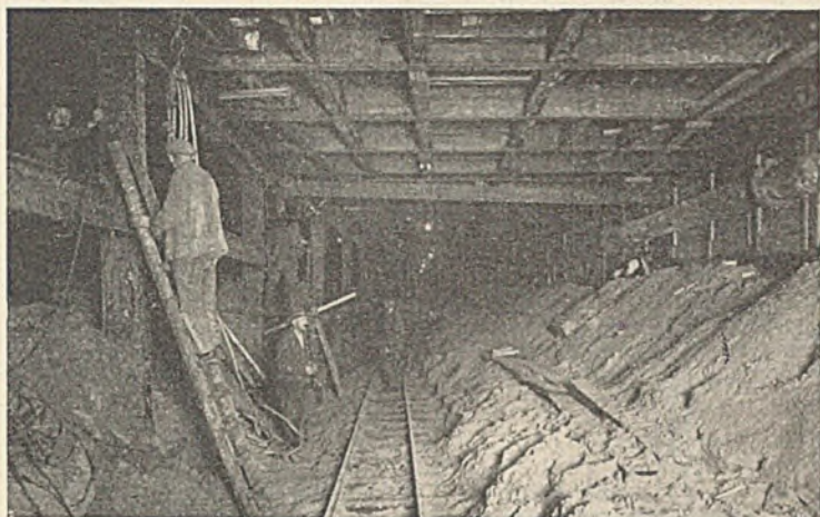
Abb. 13. Fahrschlitz unter der Fahrbahn (vergl. Abb. 2).
