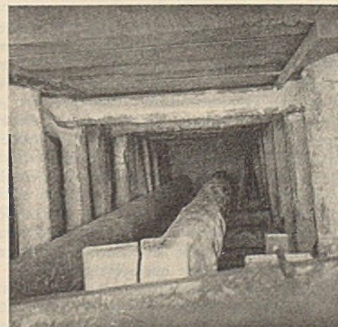
Abb. 19. Schacht 1,5 x 1,5 m mit eingebauten Stempeln.
