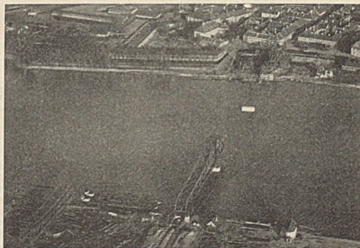
Abb. 29. Blick auf die Baustelle und Bauzustand Mitte November 1926.
