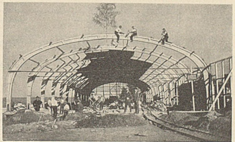
Abb. 12. Zweigelenkvollwandbinder mit Zugband während der Aufstellung.
