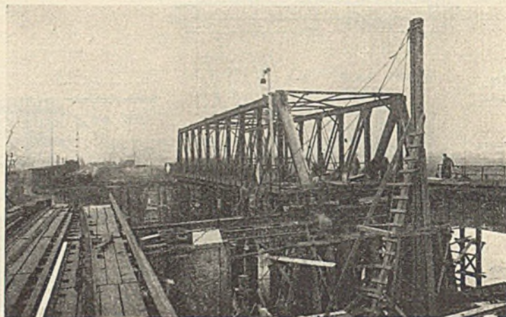
Abb. 11. Die Verschiebung des Fachwerkbaues ist fast beendet.
