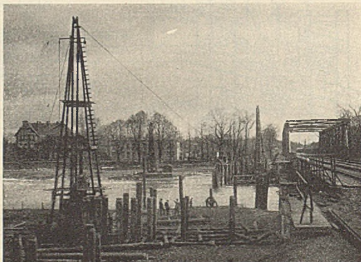
Abb. 14. Drei Rammen arbeiten gleichzeitig.
