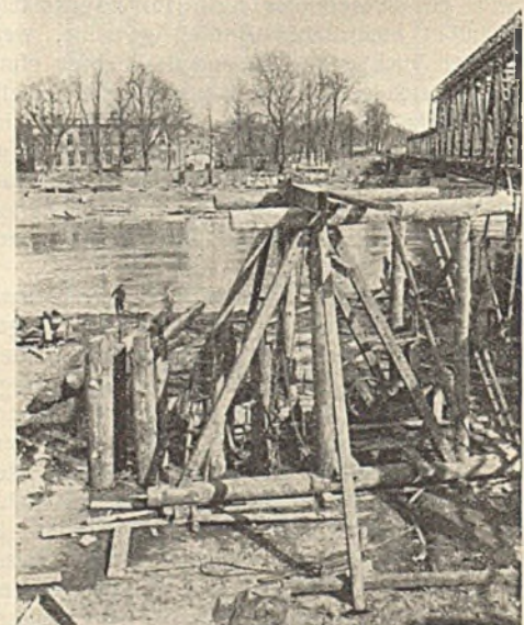
Abb. 43. Ziehen der Pfähle der Notbrücke.
