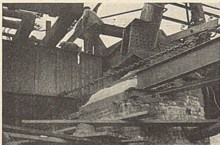
Abb. 10. Beginn des Ausfahrens eines an den Fachwerküberbau grenzenden nördlichen Blechträgers.
