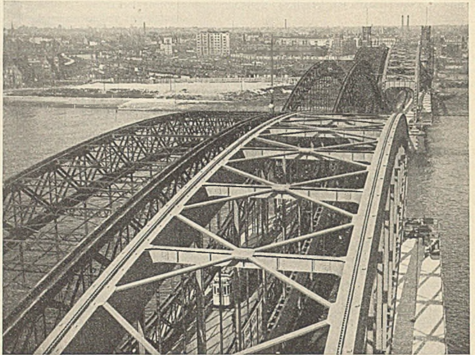
Abb. 15. Aufsicht auf alte und neue Brücke.
