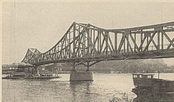
Abb. 42. Ansicht der neuen Brücke von Novi-Sad gegen Peterwardein gesehen.
