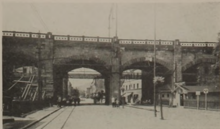
Abb. 2. Alter Viadukt in Hermsdorf.
