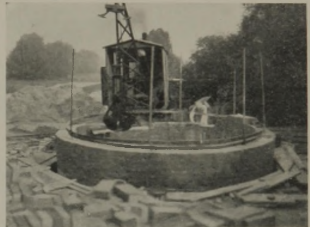
Abb. 4. Ausschachtung mittels Greifbaggers.
