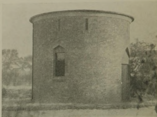
Abb. 6. Das fertige Brunnenhaus mit oberen Entlüftungsschlitz.
