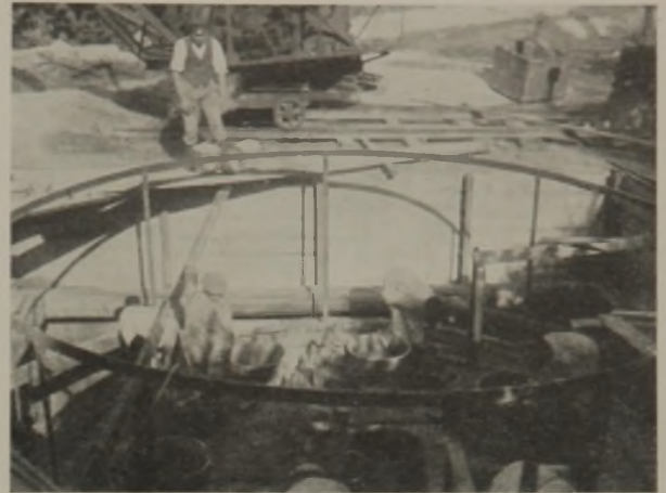
Abb. 3. Trockene Baugrube mit Aussteifung und der Bewehrung des Schachtmauerwerks durch Ringanker und Senkrechte.
