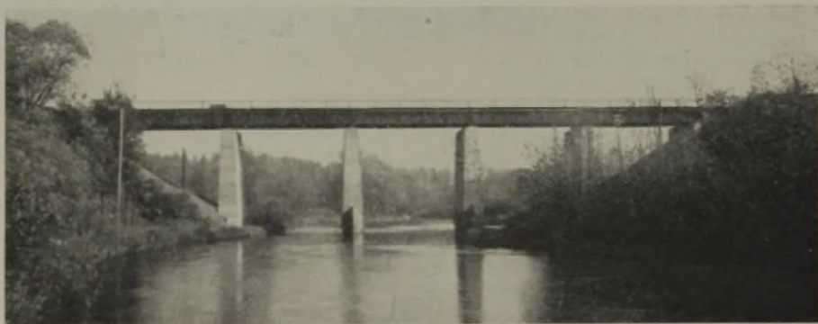
Abb. 3. Brücke über die Alle bei Bartenstein.
