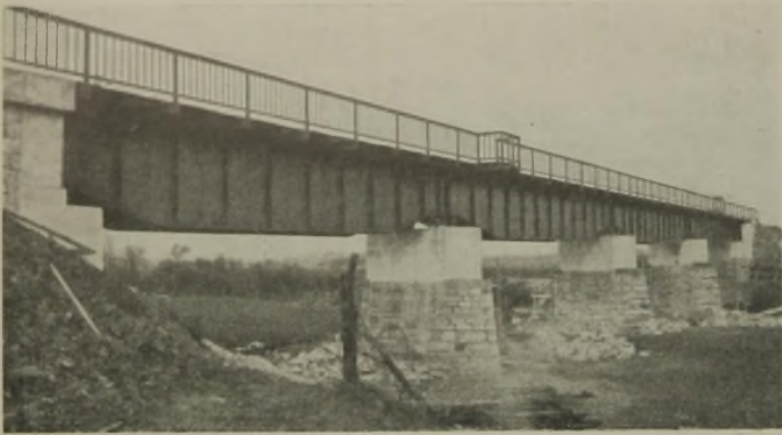
Abb. 6. Brücke über die Alme.
