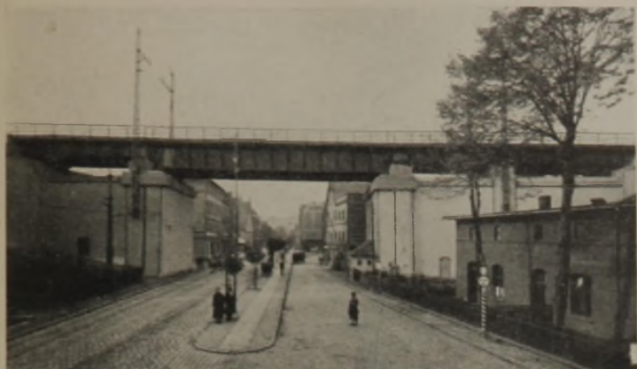
Abb. 1. Neuer Viadukt in Hermsdorf.
