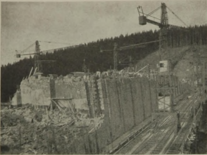
Abb. 7. Talsperre Lehmühle im Bau.
