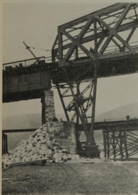
Abb. 12. Abstützung des alten Stromüberbaues während der Pfeilerumänderung und beim Ausschleppen.
