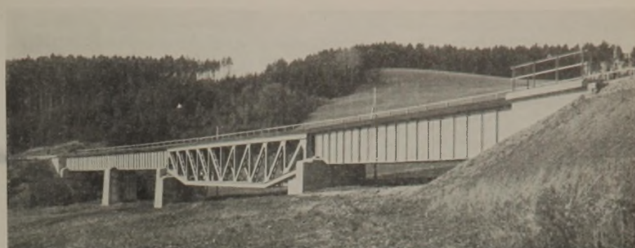
Abb. 9. Brücke über das Weiherbachtal.
