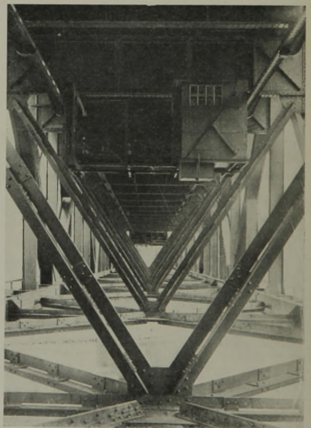
Abb. 10. Unteransicht der Fahrbahn des Stromüberbaues mit Besichtigungswagen.
