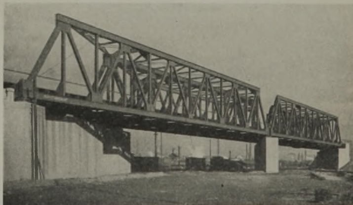
Abb. 16. Kreuzungsbauwerk auf Bahnhof Zwickau.
