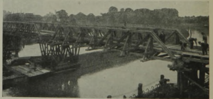
Abb. 2. Ein Tragwerk auf dem Wege zur Baustelle.
