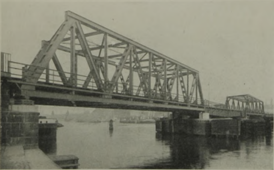
Abb. 19. Brücke über die Oder in Stettin.
