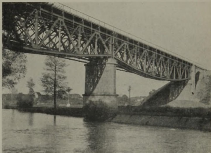
Abb. 15. Eisenbahnbrücke über die Rednitz.
