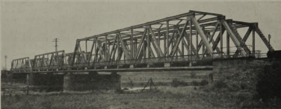
Abb. 25. Ruhrbrücke bei Fröndenberg.
