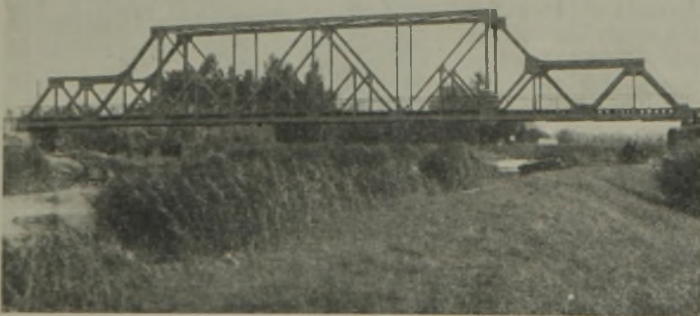
Abb. 10. Brücke über die Thiene bei Eschenhorst.
