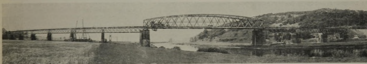
Abb. 1. Gesamtbild der alten Brücke.
