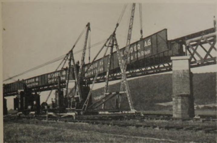
Abb. 11. Einbau der Hauptträger mit Kranen.
