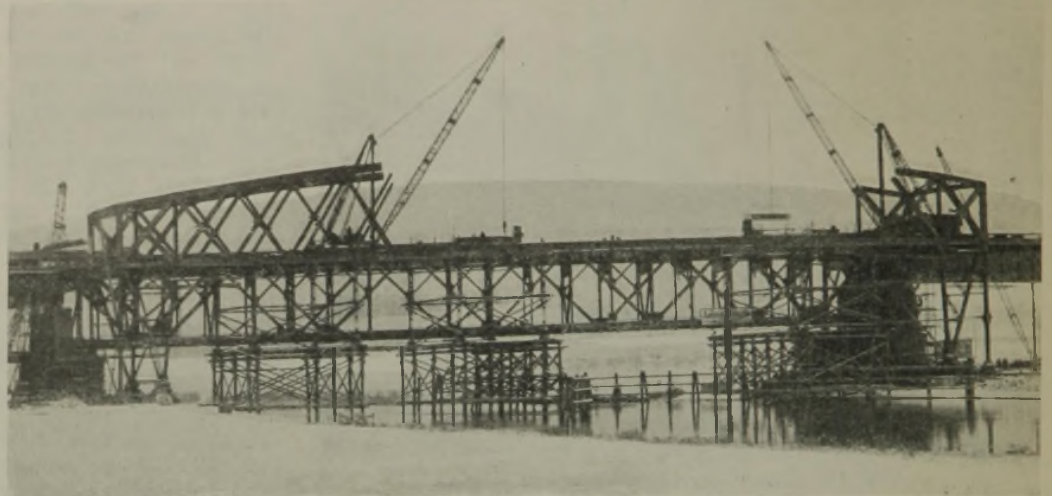
Abb. 14. Abbruch des alten Stromüberbaues.
