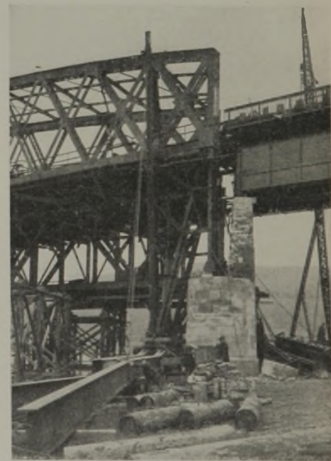
Abb. 13. Abrüstung des alten Stromüberbaues nach Aufmauerung des Pfeilers bis zum Auflagerstein.
