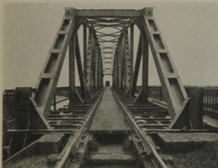
Abb. 13. Brücke über den Küstenkanal bei Sedelsberg.
