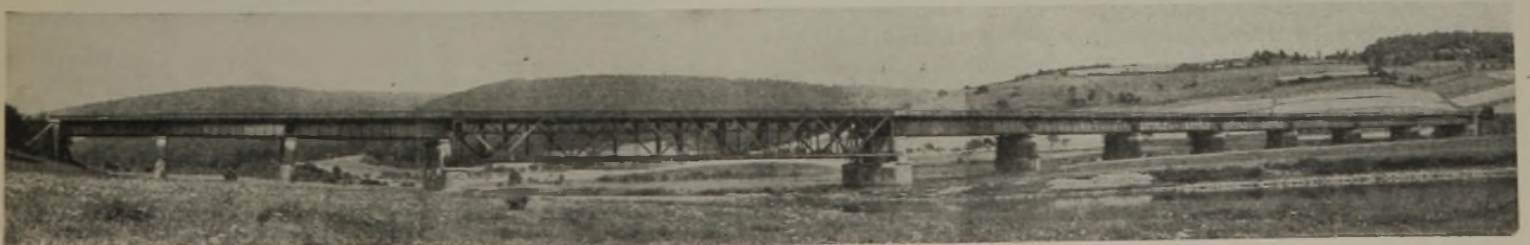
Abb. 7. Die neue Brücke.
