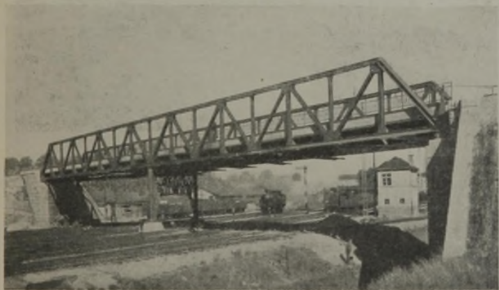
Abb. 17. Straßenbrücke in Ebersbach.
