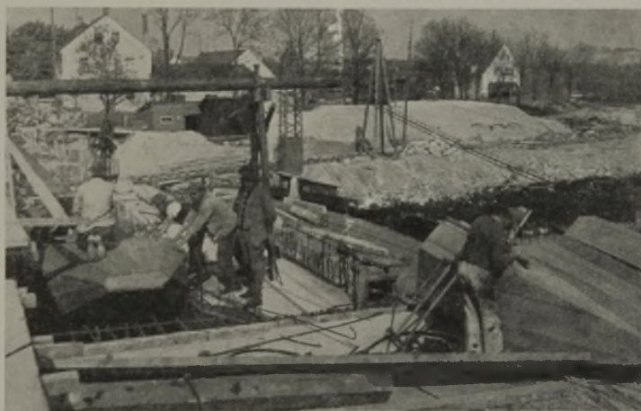
Abb. 24. Versetzen der Innenschalung am Druckhaupt im Scheitel.
