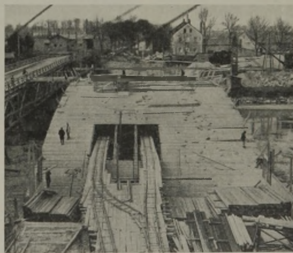
Abb. 16. Aufbringen der Bogenschalung. Das Transportgleis auf dem Untergerüst zum jenseitigen Widerlager ist noch im Betrieb.
