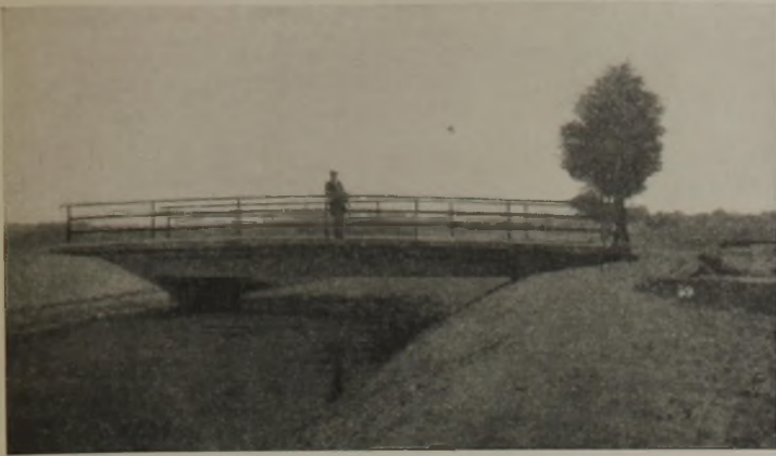
Abb. 5. Wegebrücke über das Neuteicher Mühlenfließ.
