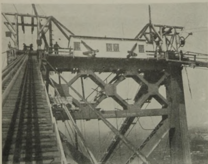
Abb. 13. Die amerikanische Hauptturmspitze zeigt vorzüglich oberen Versteifungsträger, Materialschuppen, links vier Bündel Kabel, oben links den Sattel und darüber die Holzböcke, unter denen das endlose Seil hängt. Rechts oben ein Spinnrad.
