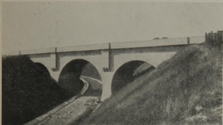
Abb. 33. Kreuzungsbauwerk im Zuge der Güterumgehungsbahn bei Stettin.
