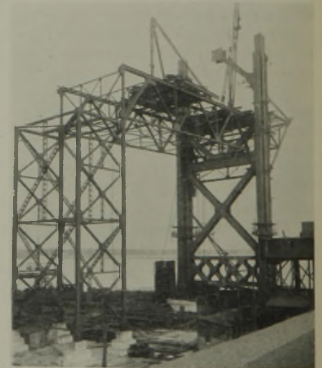
Abb. 8. Eisenkonstruktion des Hauptturms auf der amerikanischen Seite bis Fahrbahnhöhe fertiggestellt. Links die ersten Fahrbahnträger mit Unterstützung.
