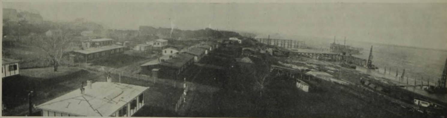
Abb. 1. Stand der Arbeiten im Januar 1928.
