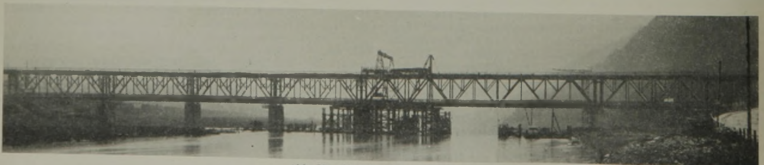
Abb. 29. Moselbrücke bei Bullay.
