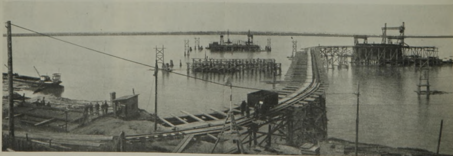
Abb. 2. Senkkasten-Montagerüst und Entladestation in der Donau mit Transportsteg zum Lagerplatz am Belgrader Ufer.
