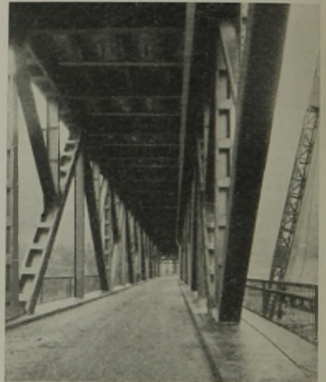
Abb. 30. Moselbrücke bei Bullay. Durchblick.
