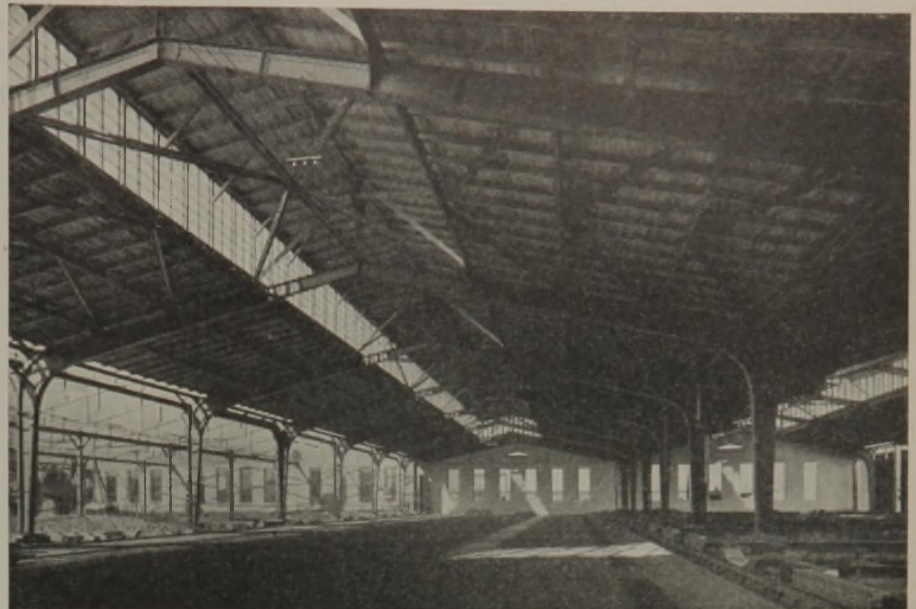
Abb. 43. Lokomotivschuppen auf dem Bahnhof Breslau-Ost.
