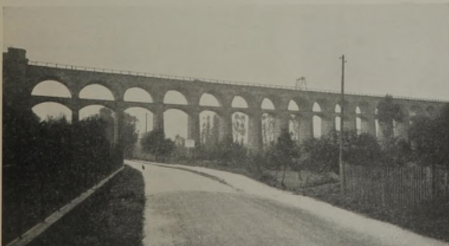
Abb. 37. Enzviadukt bei Bietigheim.
