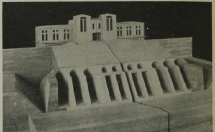
Abb. 8. Modell des Grundablaßbauwerkes Ottmachau. Ansicht von der Luftseite.
