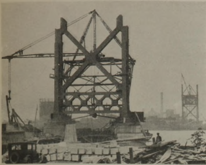
Abb. 9. Kanadischer Hauptturm im Bau. Im Hintergrunde das amerikanische Ufer.
