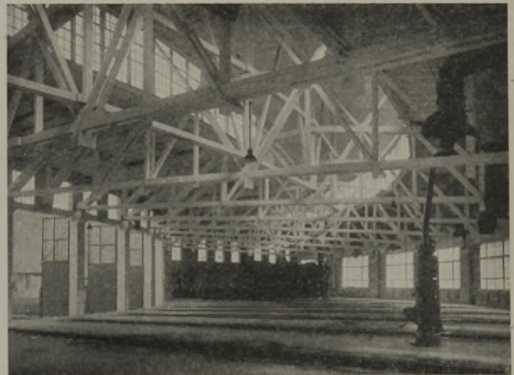
Abb. 44. Lokomotivschuppen auf Bahnhof Horb.
