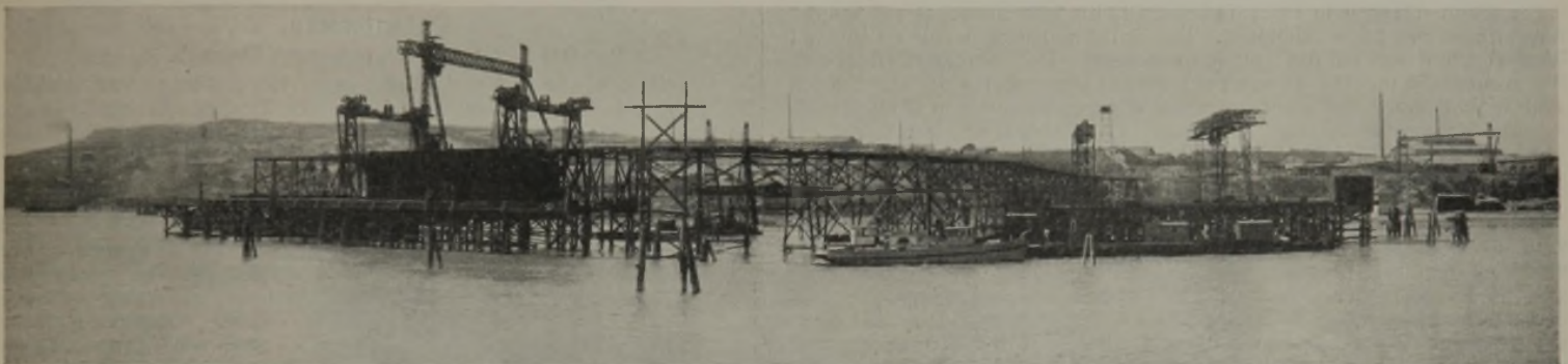
Abb. 5. Baustelle vom Wasser aus gesehen mit Stand der Arbeiten im Juli 1928.
