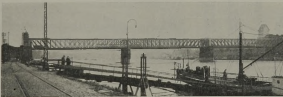
Abb. 2. Alte Rheinbrücke bei Ludwigshafen—Mannheim.
