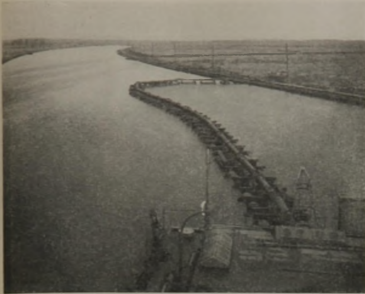
Abb. 16. Moorspülbagger „Drömling“. Blick auf die Druckleitung und Spülfeld I (im Hintergrunde).
