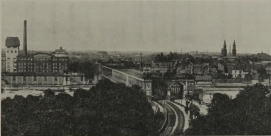
Abb. 1. Alte Rheinbrücke bei Ludwigshafen—Mannheim.
