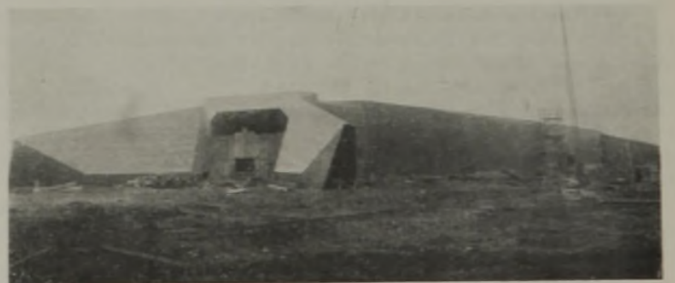
Abb. 20. Unterführung der Landstraße Rothensee—Glindenberg nach der Ausschalung.
