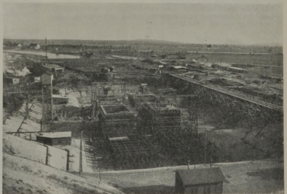
Abb. 10. Baustelle des Schiffshebewerks Niederfinow Oktober 1928.
