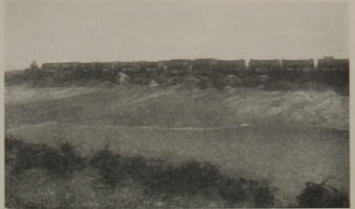
Abb. 17. Spülkippbetrieb am hohen Damm, nördlich von Magdeburg.
