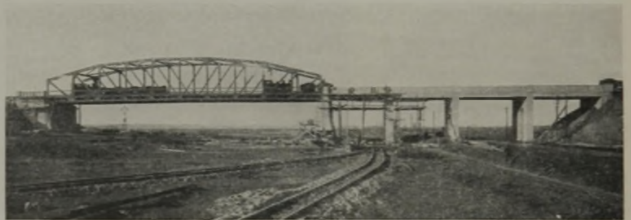
Abb. 18. Feldwegbrücke über den Mittellandkanal bei Neuahaldensleben. (52 m Lichtweite.)
