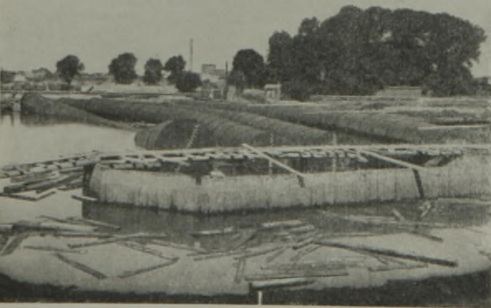
Abb. 13. Fuhsedüker, Rohr 1 wird durch Füllen der Kammern mit Wasserballast aufgerichtet.
