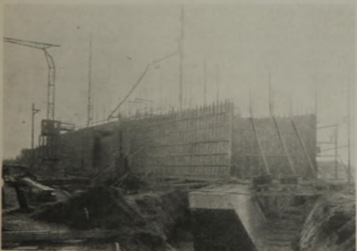
Abb. 19. Unterführung der Landstraße Rothensee—Glindenberg während der Betonierung (Länge 117 m, Lichtweite 8 m).
