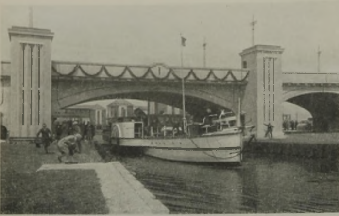
Abb. 11. Oberhaupt der Hindenburg-Schleuse. Ausfahrt des Regierungsdampfers nach der Eröffnungsfeier.
