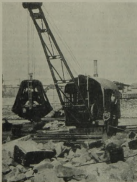
Abb. 2. Polyp mit einem schweren Steinblock über einer Schute mit Bodenentleerung.
