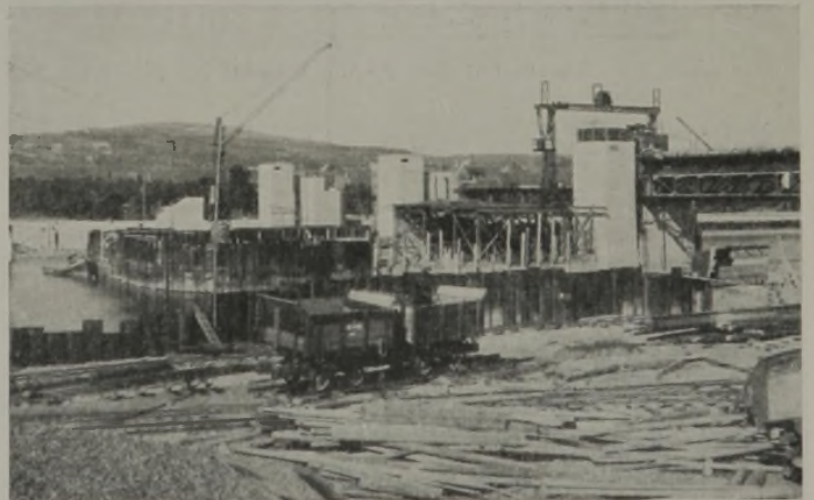
Abb. 39. Staustufe Oberrau. Wehranlage im Bau.
