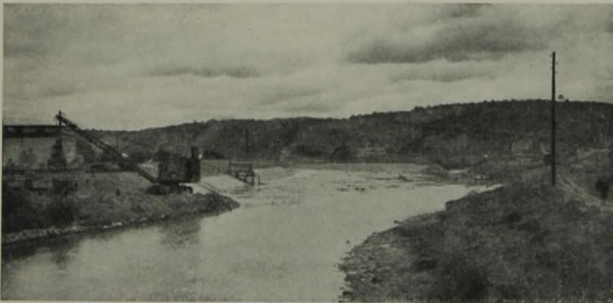
Abb. 33. Staustufe Münster. Neckardurchstich und Schließung des alten Neckar (rechts).
