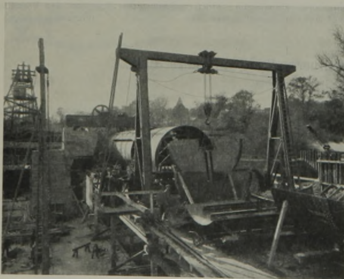
Abb. 35. Staustufe Cannstatt. Montage der linkseitigen Wehrwalze.
