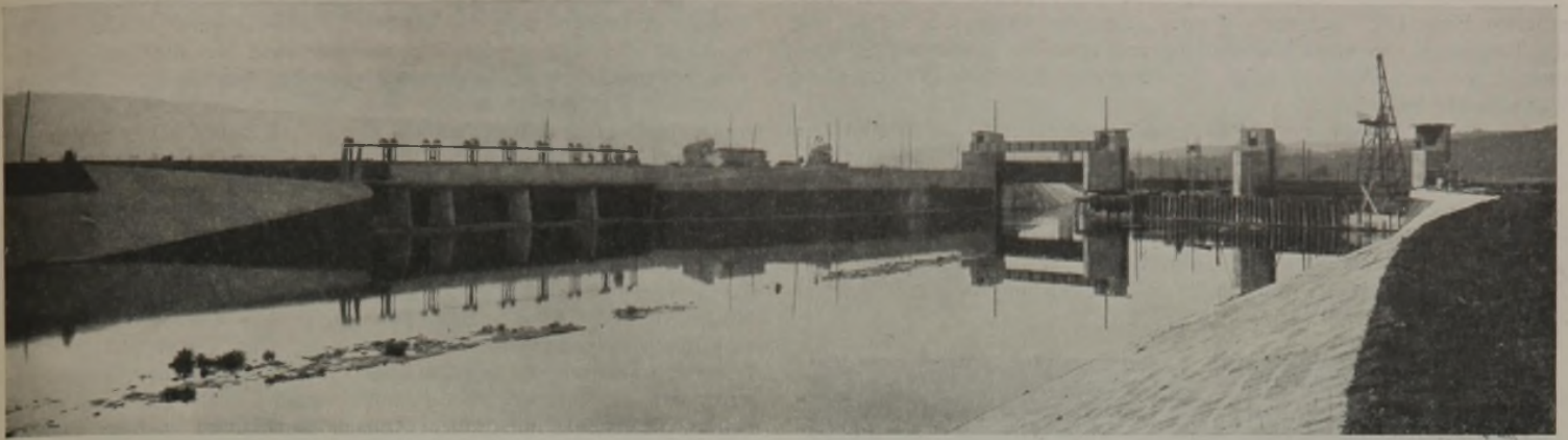
Abb. 37. Staustufe Obereßlingen. Schützenwehr und Einlaufbauwerk mit Fallenabschluß.
