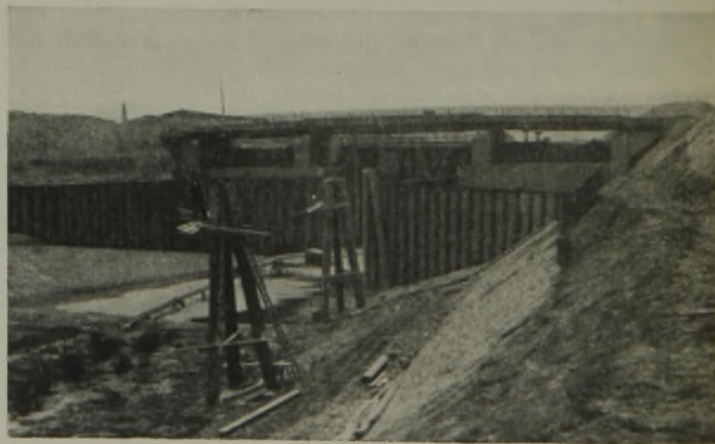
Abb. 29. Leitwerk „Schleuse Oldenburg“ vom unteren Vorhafen aus gesehen. Steinböschung von -0,80 NN bis +2,40 NN (50 cm über MHW).
