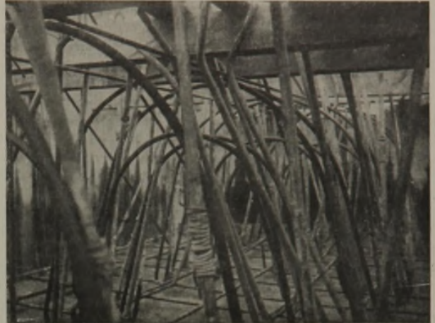
Abb. 8. Pfeilerkasten mit einem Teil der Bewehrung.
