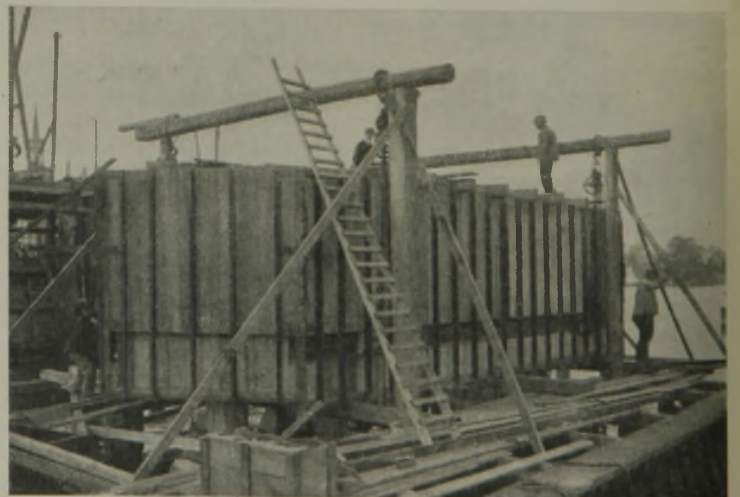
Abb. 6. Schalungskasten für Pfeiler V vor dem Absenken.
