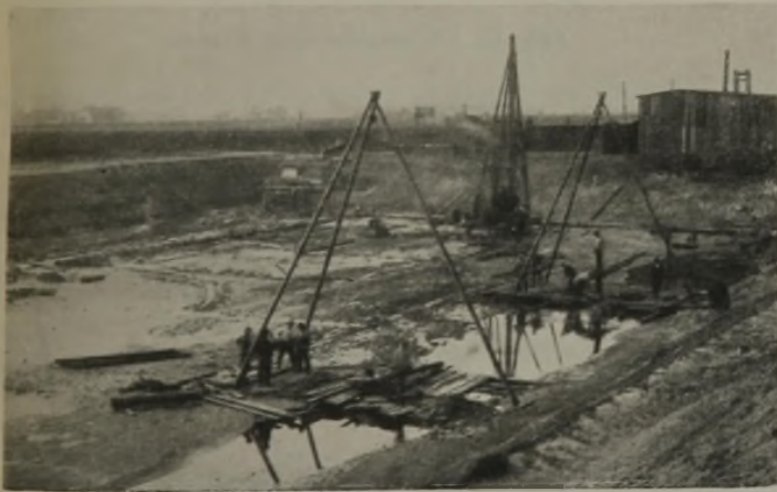
Abb. 10. Bis zur Rammebene ausgehobene Baugrube. Übergang von offener Wasserhaltung zur Grundwasserabsenkung.
