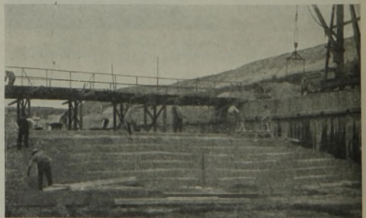
Abb. 14. Betonieren der Sohle, Transportbrücke, rechts Kran.
