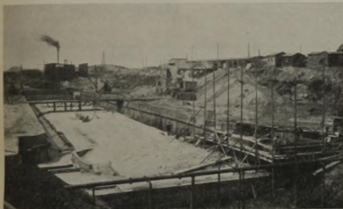
Abb. 5. Beginn der Betonarbeiten, Transportbrücke, Mischmaschinen, rechts Lagerplatz.
