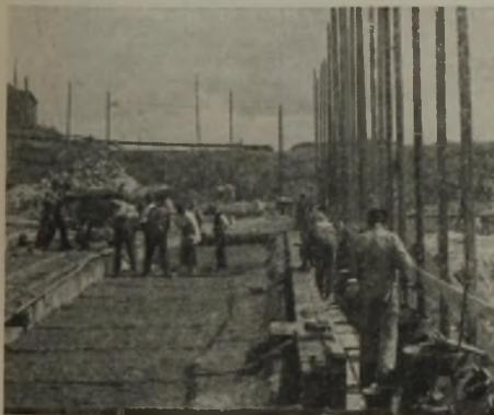
Abb. 15. Betonieren der Schleusenkammermauer mit Klinkerverblendung ohne Schalung.
