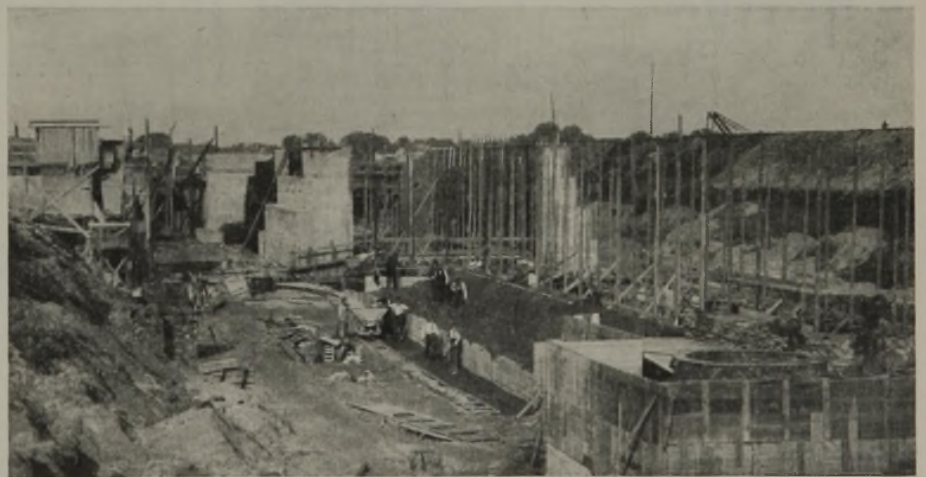
Abb. 17. Blick auf die Betonarbeiten, Baublock am Unterhaupt ist fertiggestellt, vorn wird der Zylinderschüttschacht hergestellt.
