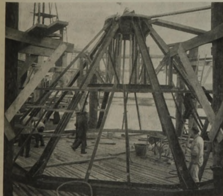
Abb. 10. Eisengerippe der Druckluftarbeitskammer für Pfeiler IV.
