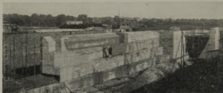
Abb. 6. Baublöcke der Schleuse mit Trennungsfuge.
