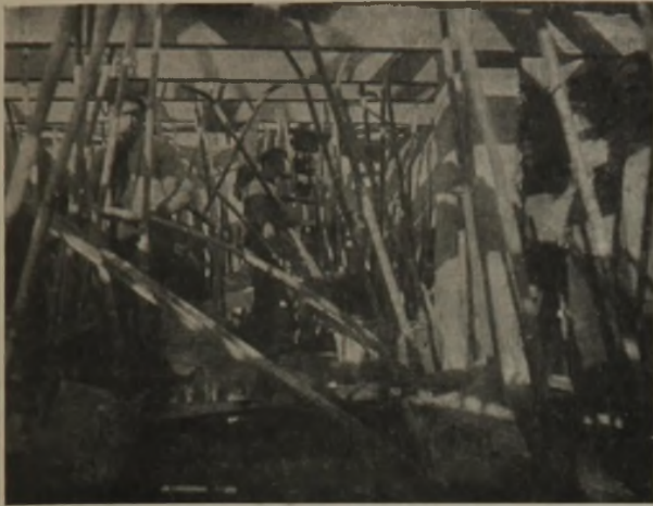
Abb. 7. Trockengelegter Pfeilerkasten nach Kappen der oberen Pfahlenden.
