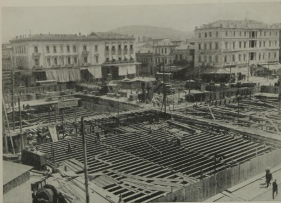
Abb. 11. Haltestelle Omoniaplatz im Bau.
