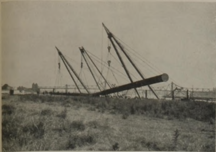
Abb. 6. Aufgehängter Rohrstrang, fertig zum Zuwasserlassen.
