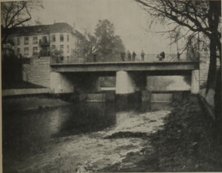
Abb. 9. Eingefahrne Schwimmwehre unter der Mansteinbrücke bei gezogenen Dammbohlen.
