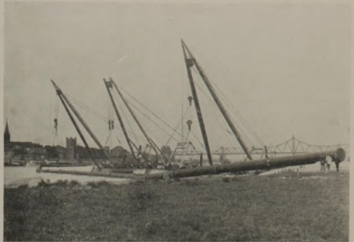
Abb. 7. Rohrstrang in der Verlegungsachse, fertig zum Absenken.
