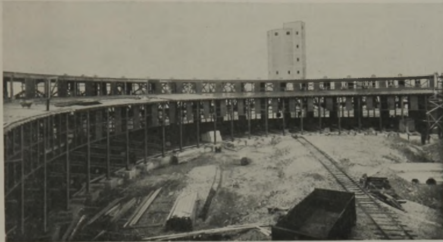
Abb. 1. Gesamtansicht des Lok-Schuppens Düren.
