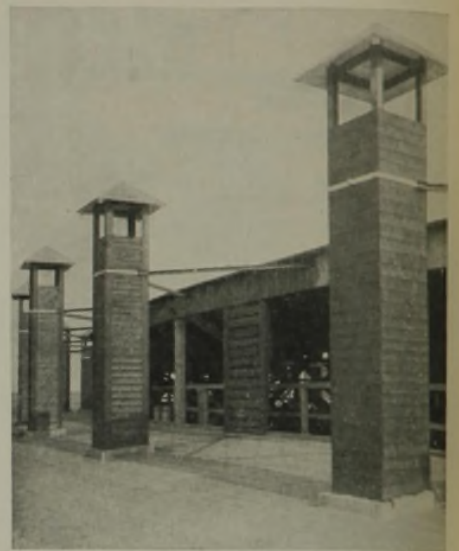
Abb. 9. Rauchabzüge mit Befestigung.
