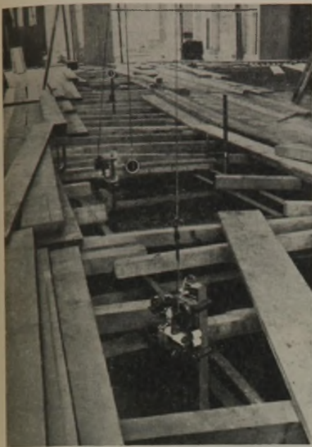
Abb. 13. Meßinstrumente am Binderuntergurt aufgehängt.
