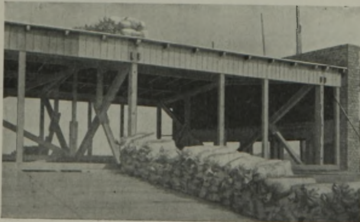
Abb. 11. Belastungsprobe durch Sandsäcke.
