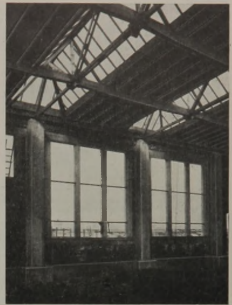
Abb. 17. Einsicht in den Anbau.
