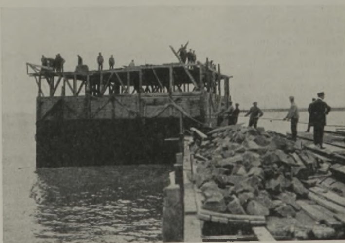
Abb. 5. Hafen Helgoland. Senkkasten für den Ostmolenkopf im Begriffe, abgesenkt zu werden.
