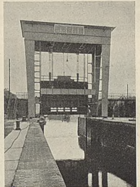
Abb. 5. Hubtor der Schleuse Kersdorf (Tor gehoben).
