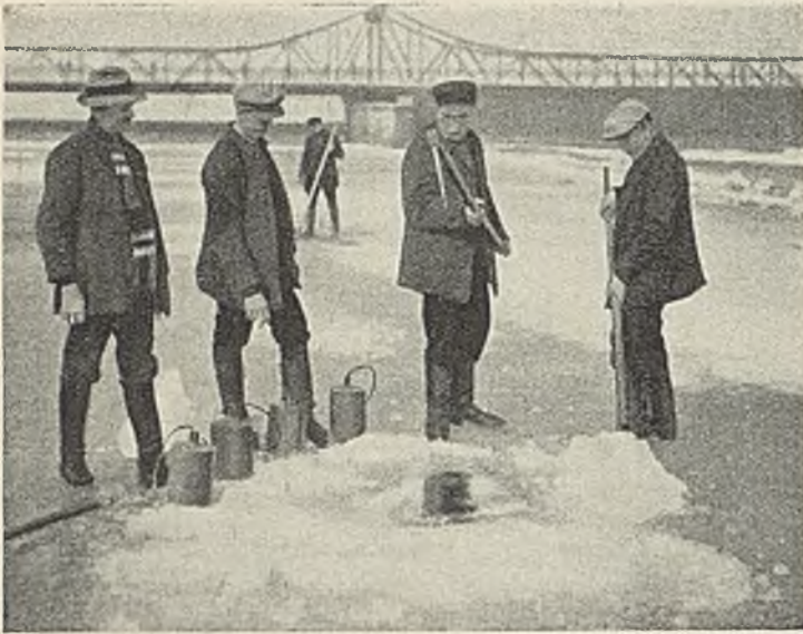
Abb. 1. Eis-sprengungen an der Schleuse Bartheln bei Breslau. Herstellen der Eislöcher mittels Eishacke; rechts neben dem fertigen Loch vier mit Schwarzpulver gefüllte Pulverkannen.
