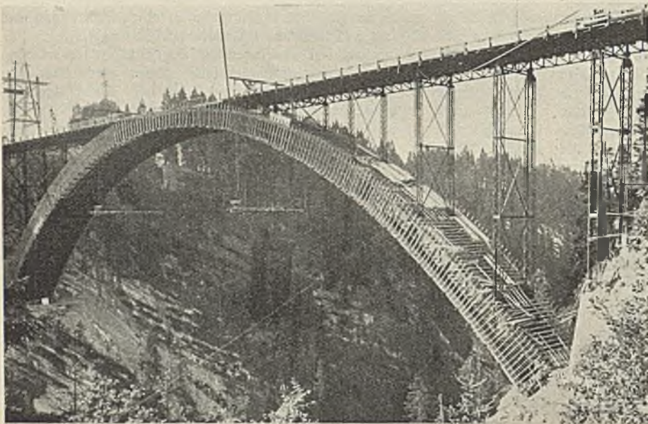
Abb. 14. Ansicht des Bogens während der Einschalung.
