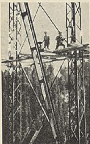
Abb. 11. Rüstung der Nietkolonne.
