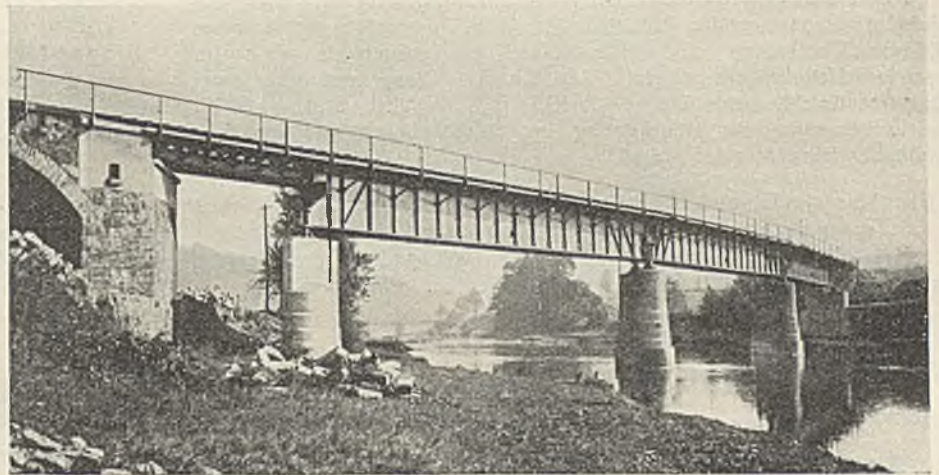
Abb. 11. Zschopaubrücke bei Braunsdorf.
