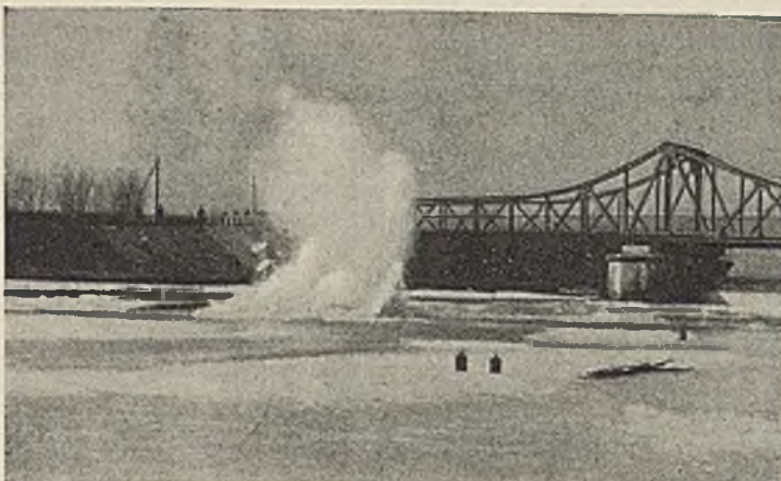
Abb. 3. Eis-sprengungen an der Schleuse Bartheln bei Breslau. Ein Sprengschuß auf dem Eis mittels Schwarzpulver.
