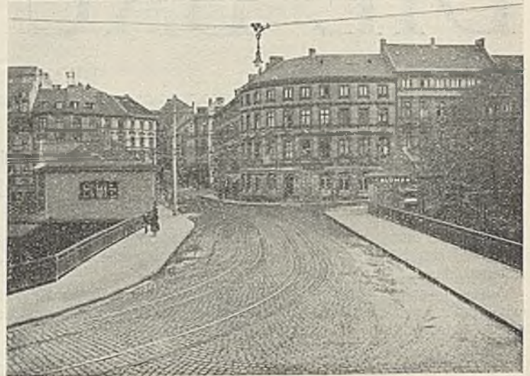
Abb. 4. Blücherbrücke in Elberfeld. Neue Brücke.
