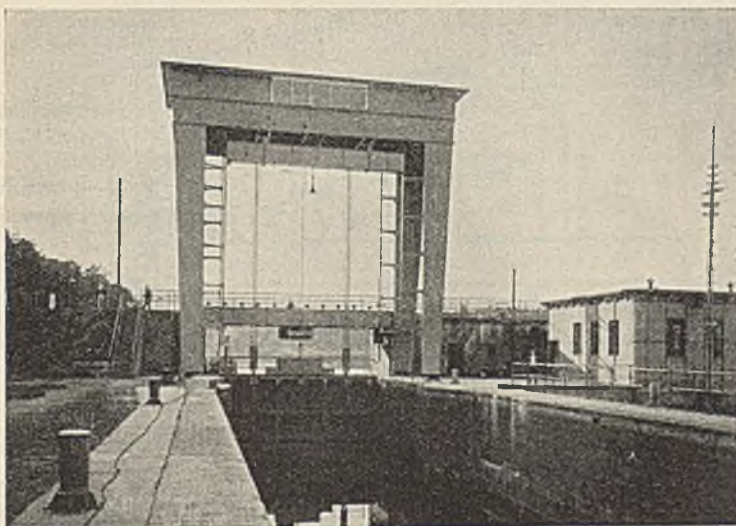
Abb. 4. Hubtor der Schleuse Kersdorf (Tor gesenkt).
