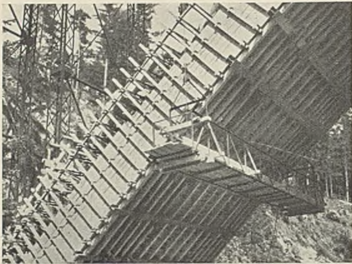
Abb. 13. Hängegerüst und Schalungsuntersicht.
