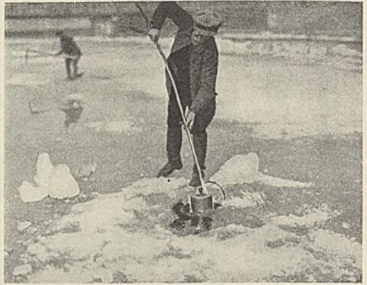
Abb. 2. Eis-sprengungen an der Schleuse Bartheln bei Breslau. Die Pulverkanne wird mittels eines Holzstabes unter das Eis gebracht.
