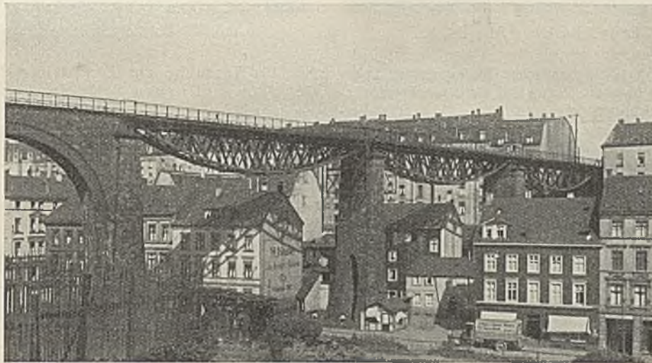
Abb. 1. Brücke in Barmen-Rittershausen. Alte Überbauten.
