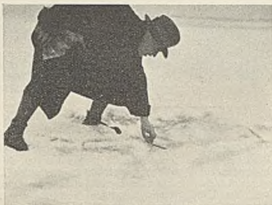
Abb. 6. Herstellung eines Sprengloches durch Auflegen von 200 g Ammongelatine 1 auf der Elbe.
