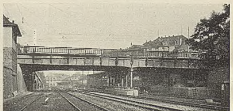
Abb. 5. Blücherbrücke in Elberfeld. Neue Brücke.
