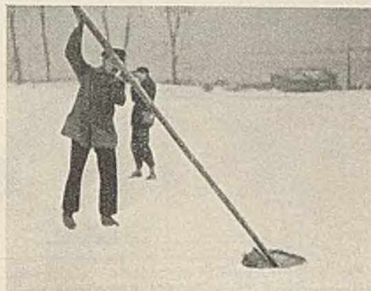
Abb. 9. Versenken der Sprengladung mittels der Sprengstange unter das Eis.
