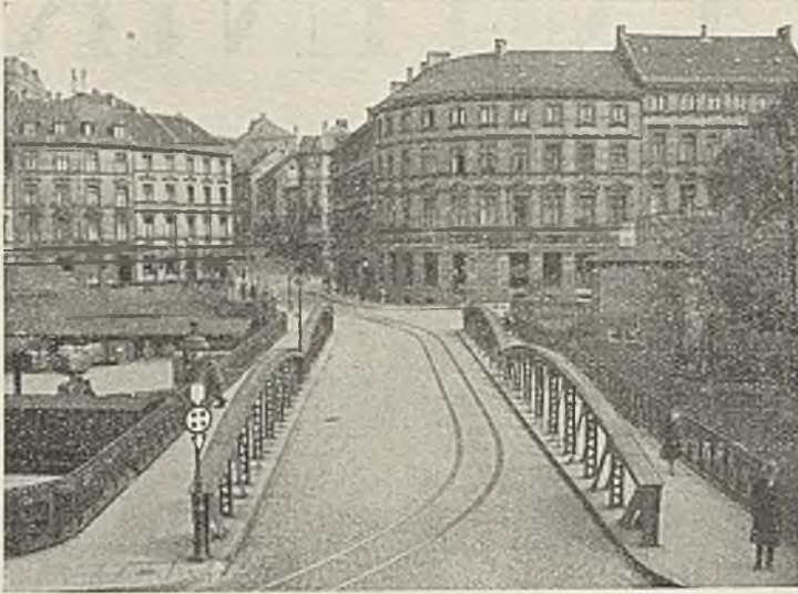
Abb. 3. Blücherbrücke in Elberfeld. Alte Brücke.
