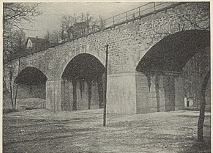
Abb. 10. Brücke bei km 83,1 nach Instandsetzung vor Ausführung der wasserdichten Abdeckung.
