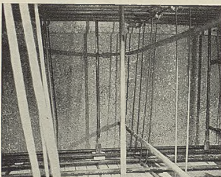
Abb. 25. Stirnansicht des ausgeschalteten mittleren Gewölberinges.
