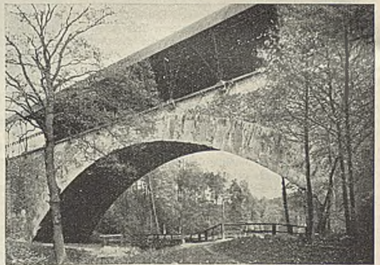
Abb. 6. Brücke mit Schutzdach.
