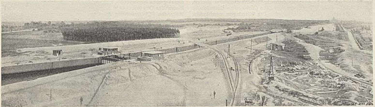
Abb. 14. Schleuse Groß-Wusterwitz. Übersicht über die Baustelle.
