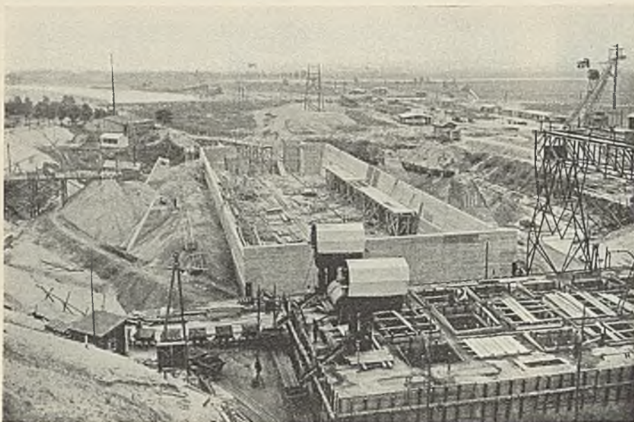
Abb. 10. Schiffshebewerk Niederfinow. Trogkammern und unterer Vorhafen.
