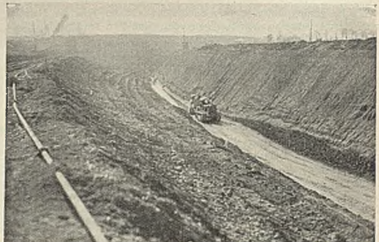
Abb. 5. Staudamm Ottmachau. Schlitzbaugrube zum Einbringen der Grunddichtung.
