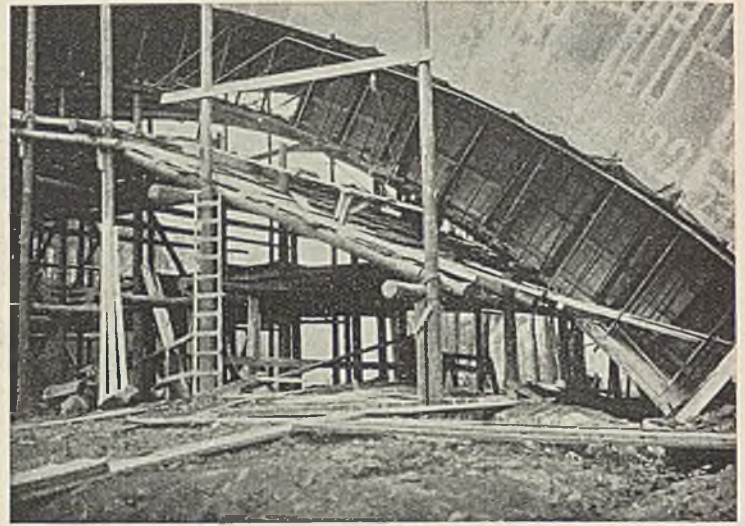
Abb. 24. Stirnschalung des mittleren Gewölberinges.
