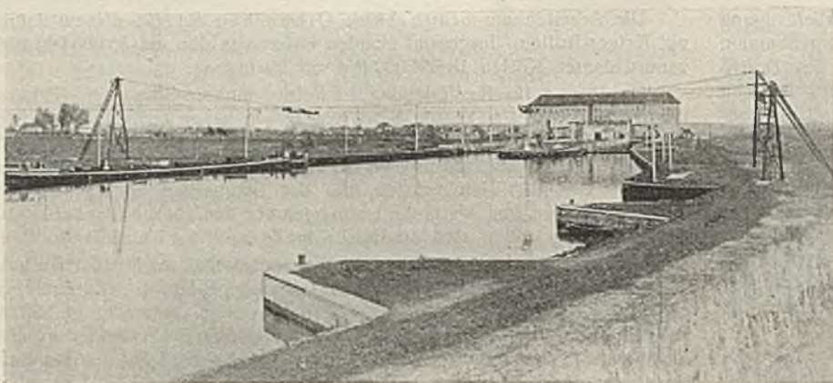
Abb. 11. Zwillingsschleuse Fürstenberg. Ansicht vom Oberwasser mit Schiffseilzug.
