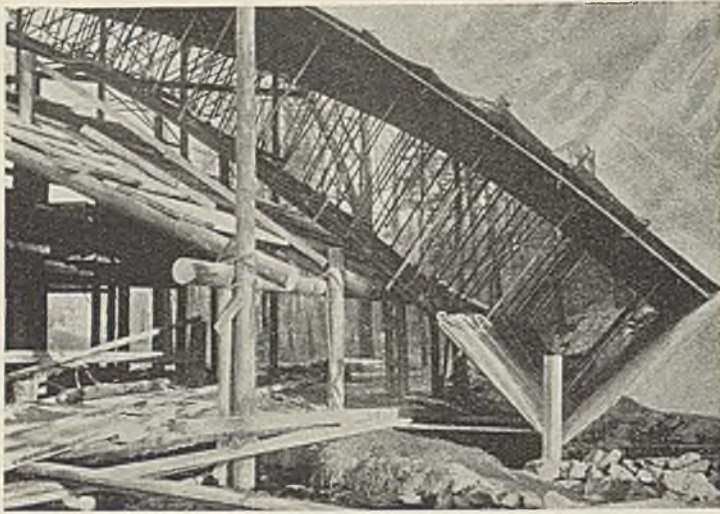
Abb. 22. Aufhängung der Schalungsträger.
