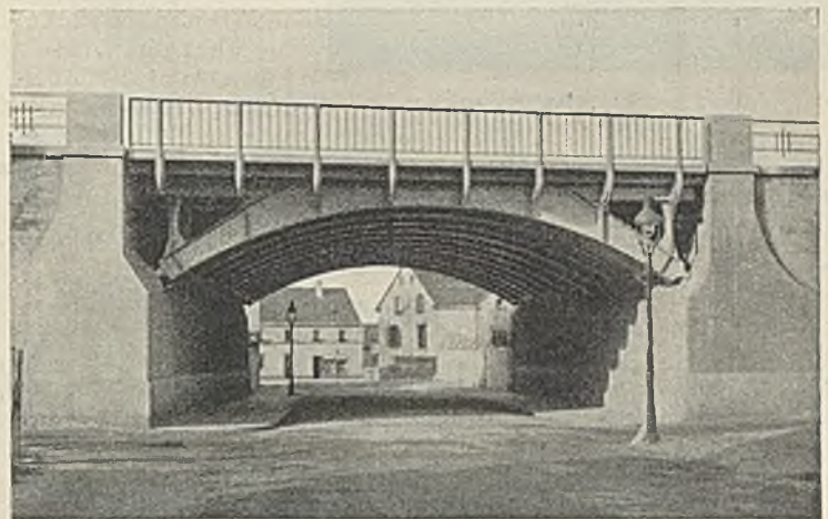
Abb. 21. Unterführung der Zieglerstraße in Duisburg.
