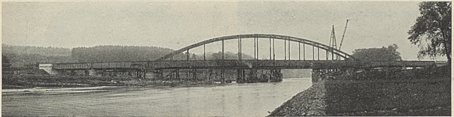
Abb. 20. Weserbrücke bei Höxter.
