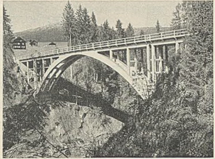
Abb. 7. Ansicht der fertigen Brücke vom rechten Ufer.
