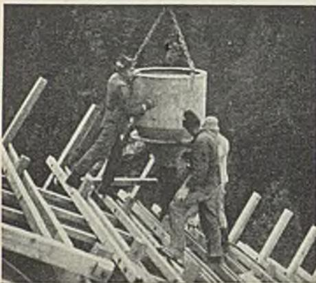
Abb. 15. Einfüllen der Kieselbelastung.
