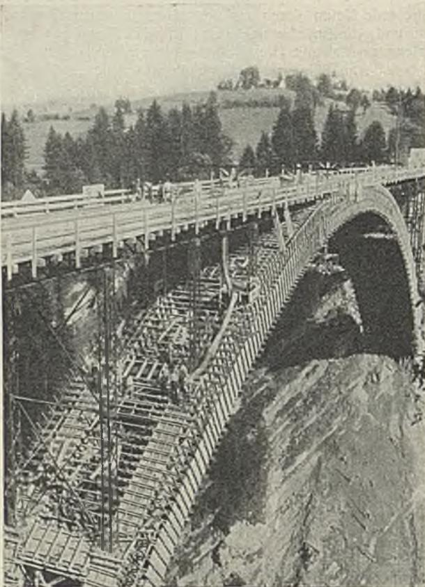
Abb. 23. Bogenbetonierung.
