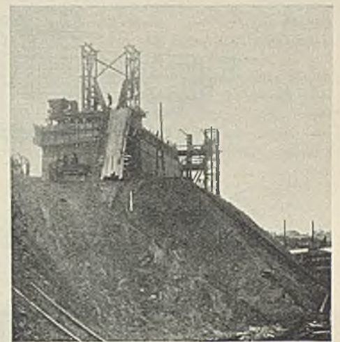
Abb. 11. Westwiderlager. Senkkasten auf der hohen Schüttung bereit zur Absenkung.
