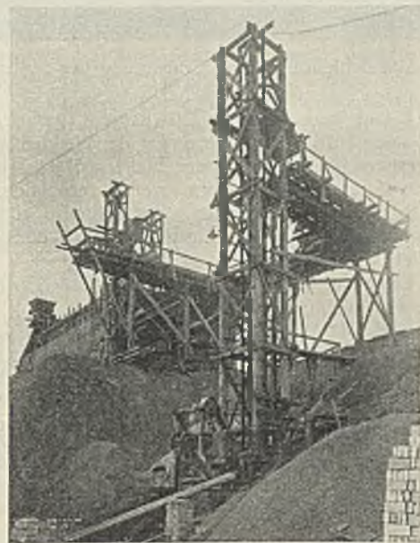
Abb. 18. Westwiderlager. Mischanlage, Betonförderturm.
