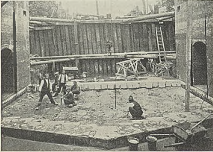
Abb. 29. Alte Schleuse Hüntel, Erneuerung der zerstörten Sohle.
