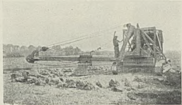
Abb. 42. Staustufe Griesheim, kl. Bagger mit Schieberschaufel.
