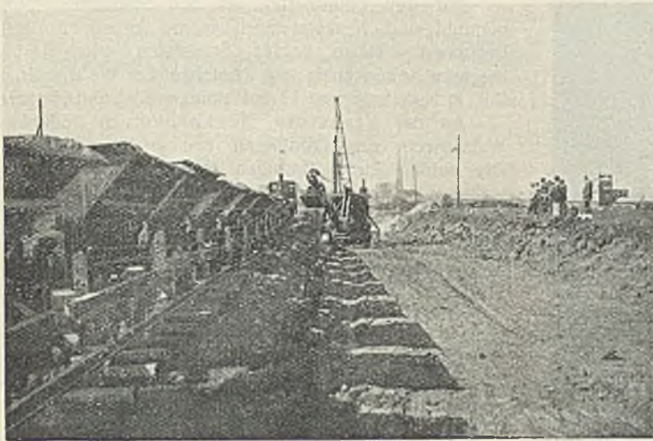
Abb. 41. Staustufe Griesheim, kl. Bagger, dahinter Ramme.
