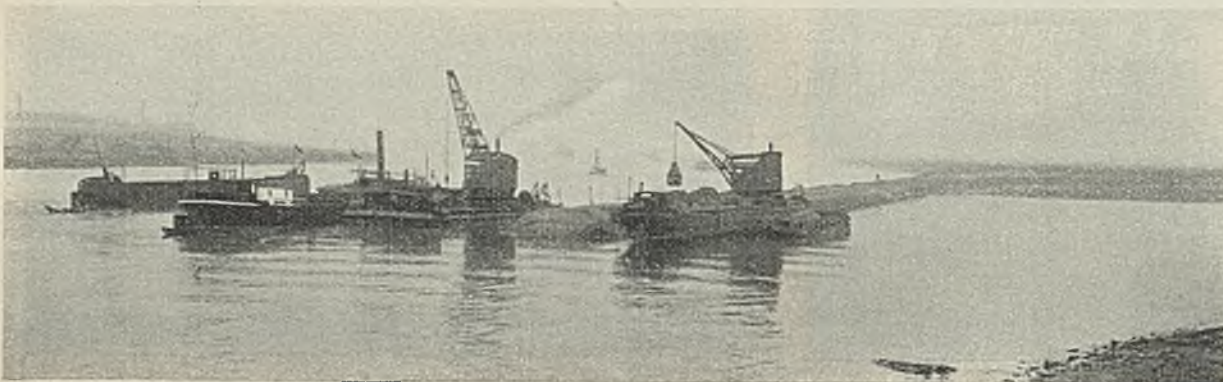
Abb. 39. Bau des Parallelwerkes bei Homberg-Essenber.
