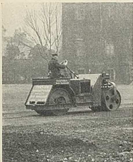
Abb. 6a. 3,5 t-Motor-Tandemwalze beim Sportplatzbau.
