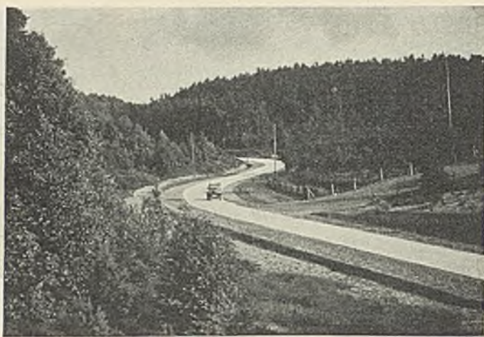
Abb. 10. Die fertige Straße.
