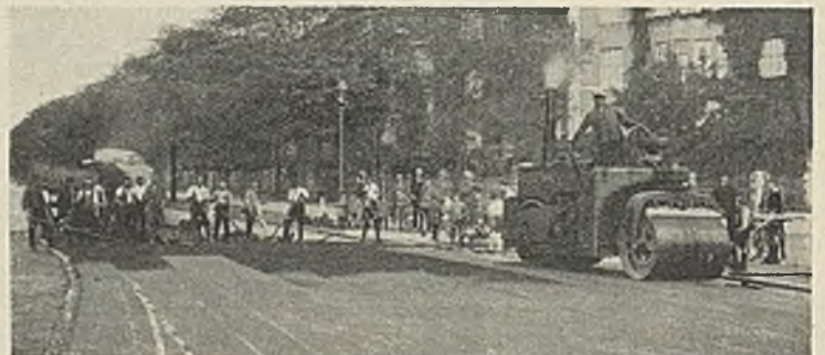
Abb. 5. 7,5 t-Heißdampf-Dreiradwalze beim Asphalt-Straßenbau.
