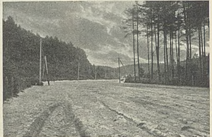
Abb. 2. Vor dem Ausbau.
