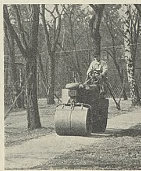
Abb. 6c. 2,2 t-Motor-Tandemwalze beim Walzen eines Parkweges.
