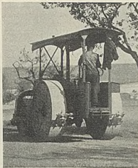
Abb. 6b. 8,5 t-Dieselmotor-Dreiradwalze beim Walzen von Teermakadam.
