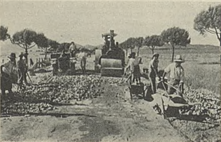
Abb. 4. 14 t-Heißdampf-Dreiradwalze bei Walzarbeiten auf der Straße Rom—Civitavecchia.
