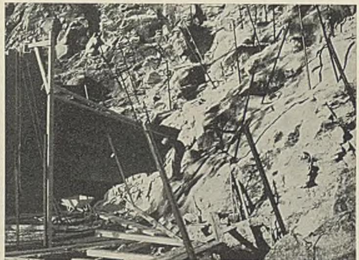
Abb. 8. Dichtung des rechten Felshanges durch Zementeinspritzungen. (Rohre in vorgebohrten Löchern.)
