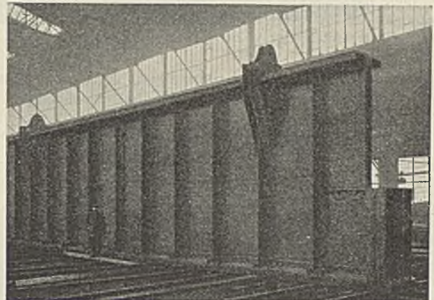
Abb. 42. Versandfertigtes Stück eines Hauptträgers der Flutbrücken.
