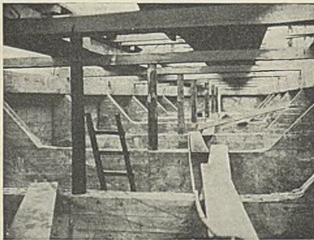
Abb. 40. Blick in den Trog des Senkkastens VII mit den Aussteifungsrippen.
