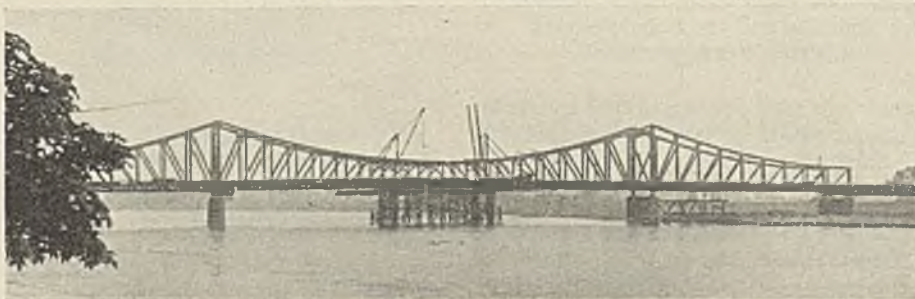
Abb. 49. Bauzustand im Mai 1929.
