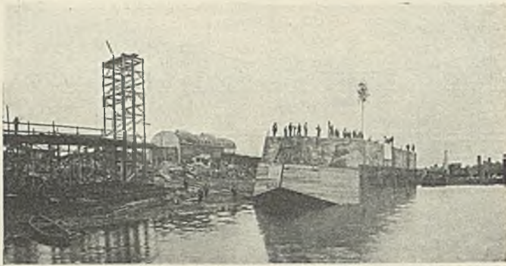
Abb. 38. Stapellauf des Senkkastens VII.
