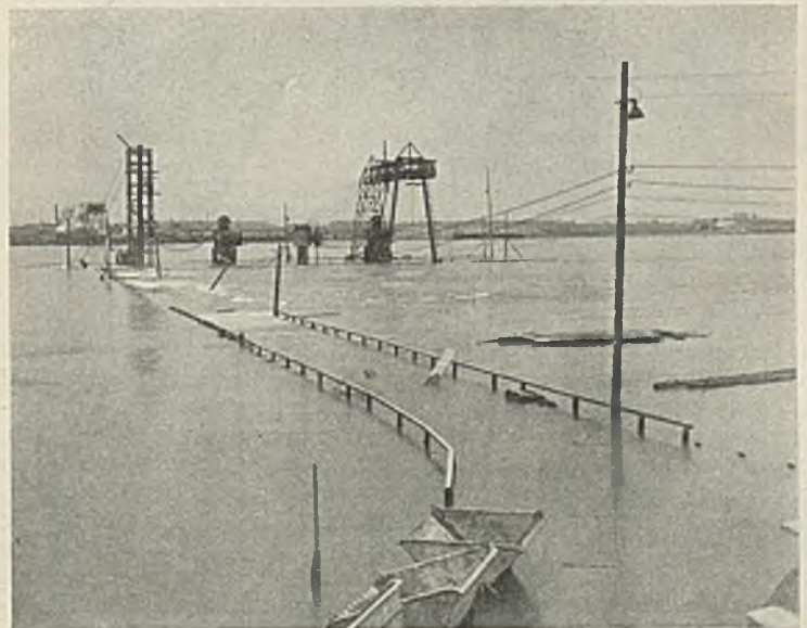
Abb. 37. Hochwasser auf der Pfeilerbaustelle im September 1927.
