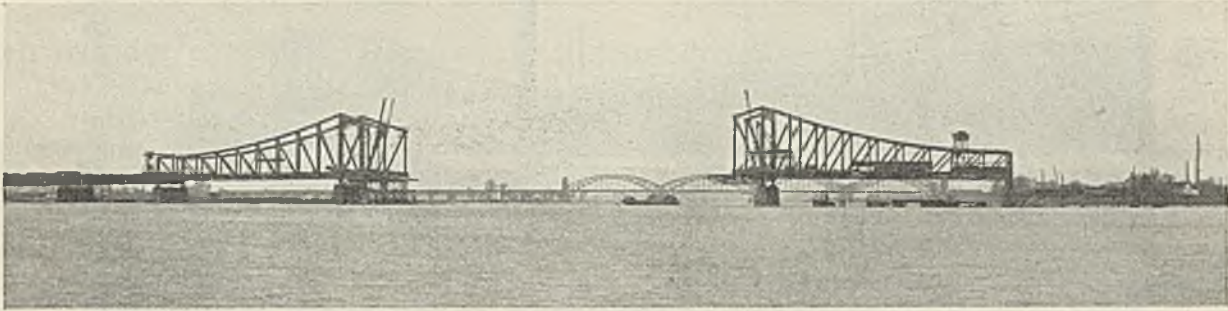
Abb. 47. Bauzustand am Ende des Sommerbauabschnittes 1928.
