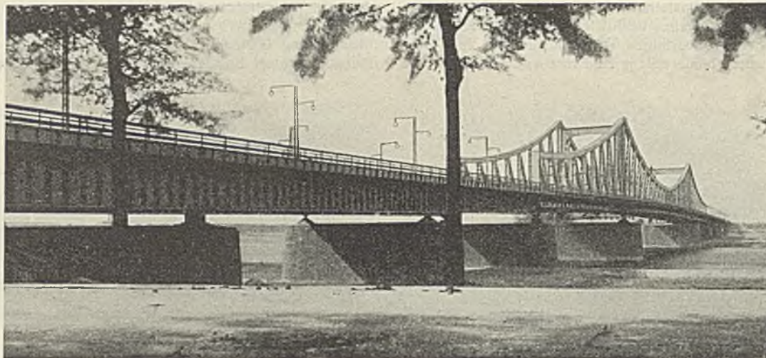
Abb. 50. Die fertige Brücke.
