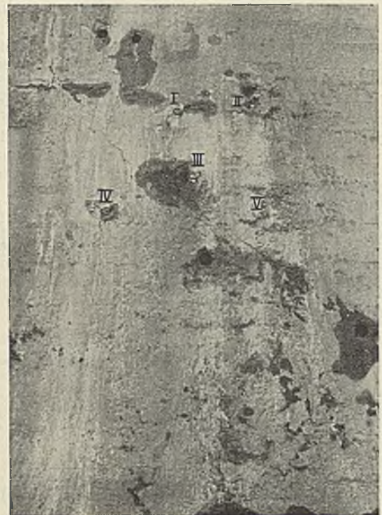
Abb. 14. Abdichtungsarbeiten im Dock VI in Kiel. Die in Abb. 12 u. 13 dargestellte undichte Stelle nach dem Verpressen.
