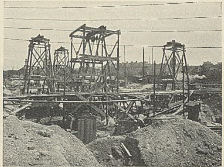
Abb. 6. Baustelle mit Bohrtürmen.
